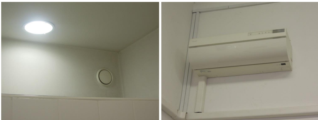
Slika 21: Odzračevanje v sanitarijah (levo) in split enota (desno)
