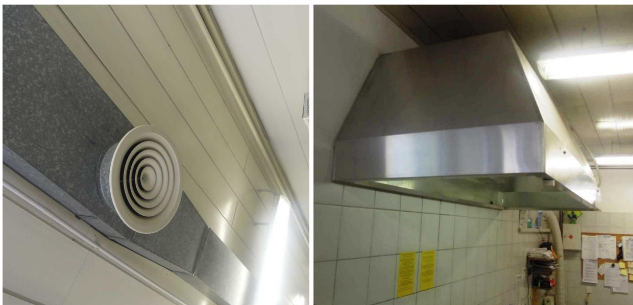
Slika 22: Odzračni ventilator (levo) in odvodna napa (desno)
