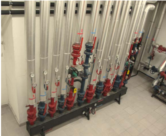
Slika 18: toplotna podpostaja in izolirani cevovodi po kleti
