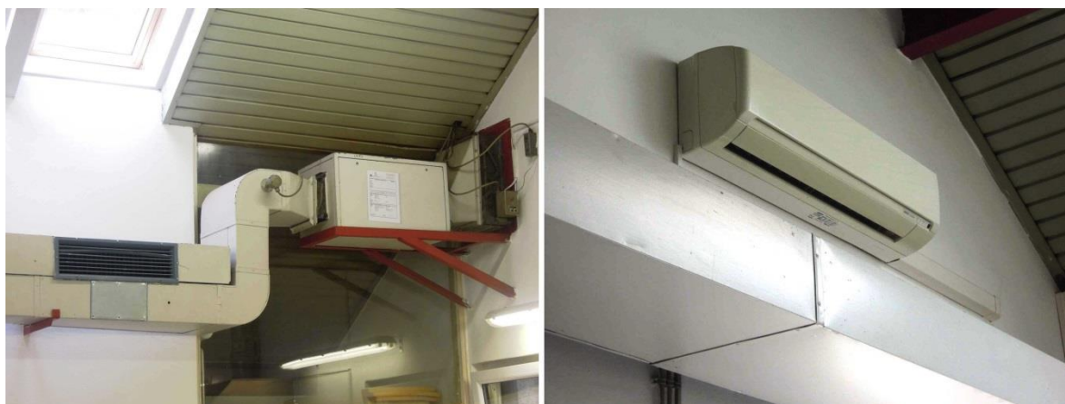
Slika 23: Sistem mehanskega prezračevanja (levo) in lokalnega ohlajevanja (desno)
