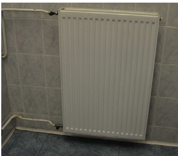
Slika 20: Radiator brez termostatskega ventila 17
