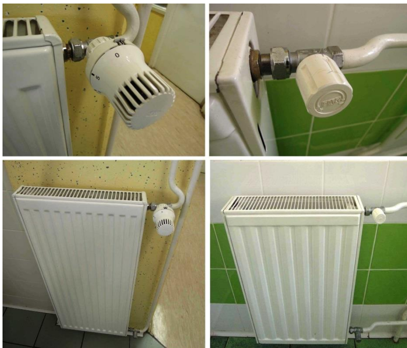
Slika 18: Radiatorska ogrevala in povečan detajl ventilov
