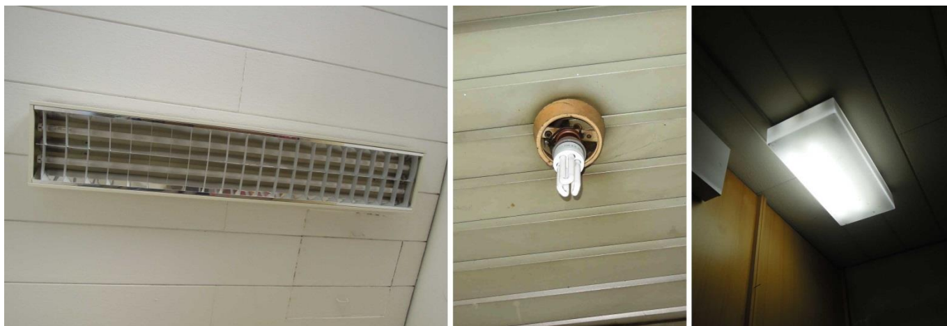
Slika 22: Fluorescentne sijalke (levo in desno), ter varčna sijalka (sredina)
