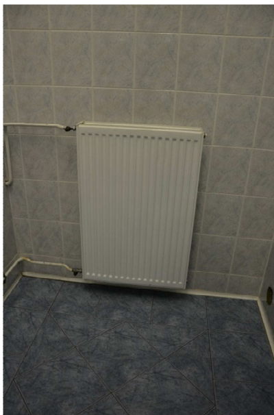
Slika 14: Ploščati radiator 8
