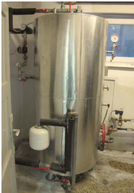
Slika 21: zalogovnik tople sanitarne vode
