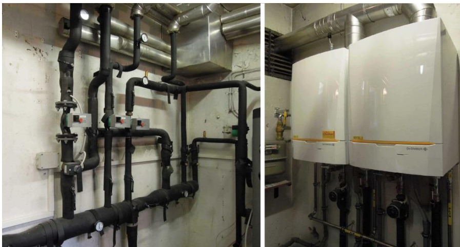
Slika 17: Razdelilnik ogrevanja (levo) in plinska kotla (desno)
