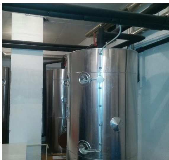
Slika 17: Bojlerji za toplo sanitarno vodo
