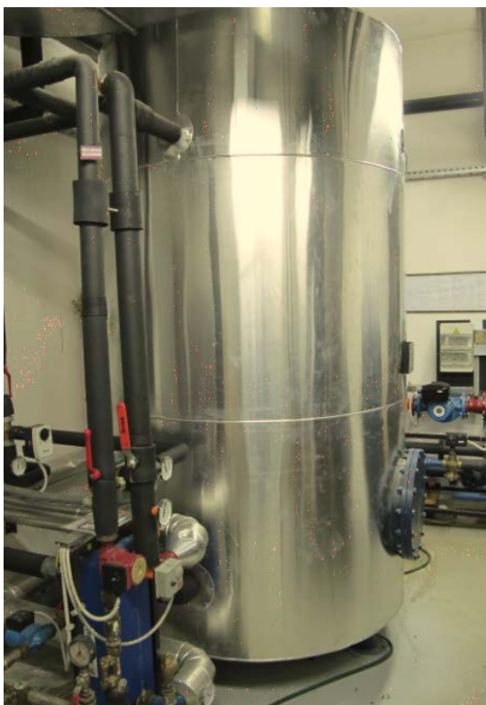
Slika 21: zalogovnik tople sanitarne vode
