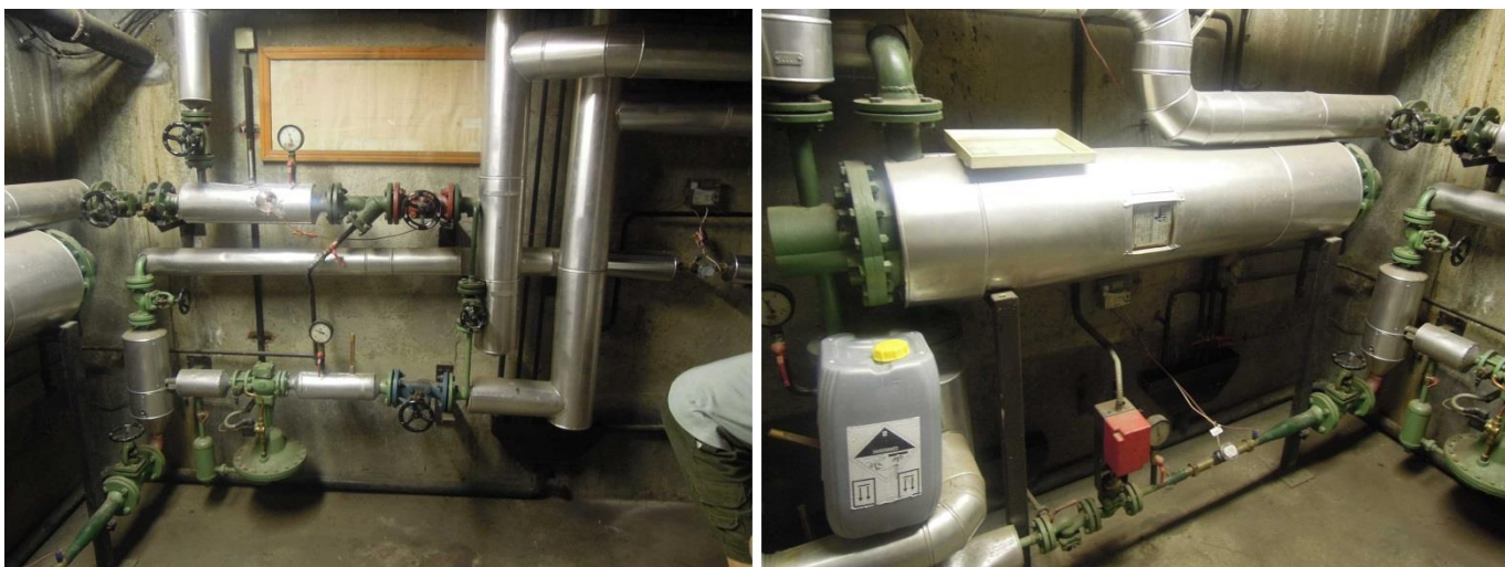
Slika 17: Razdelilnik ogrevanja (levo) in prenosnik toplote (desno)
