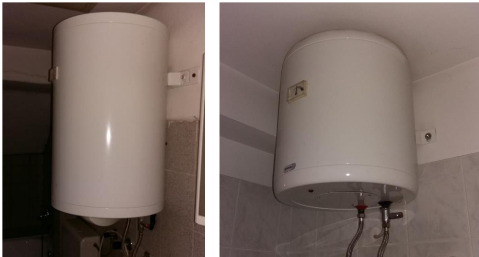
Slika 5: Bojlerji za toplo sanitarno vodo
