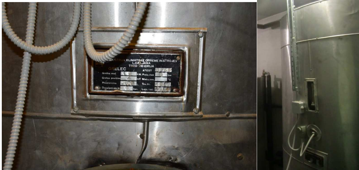
Slika 15: Posnetek bojlerja prostornine 2000 litrov (desno) in napisna tablica (levo) 9
