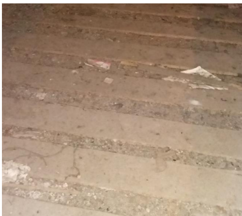
Slika 6: Neizolirano podstrešje
