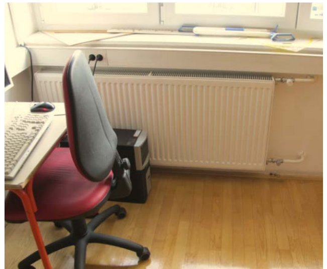
Slika 19: Radiatorsko ogrevanje (levo s v razredu, desno v sanitarijah)
