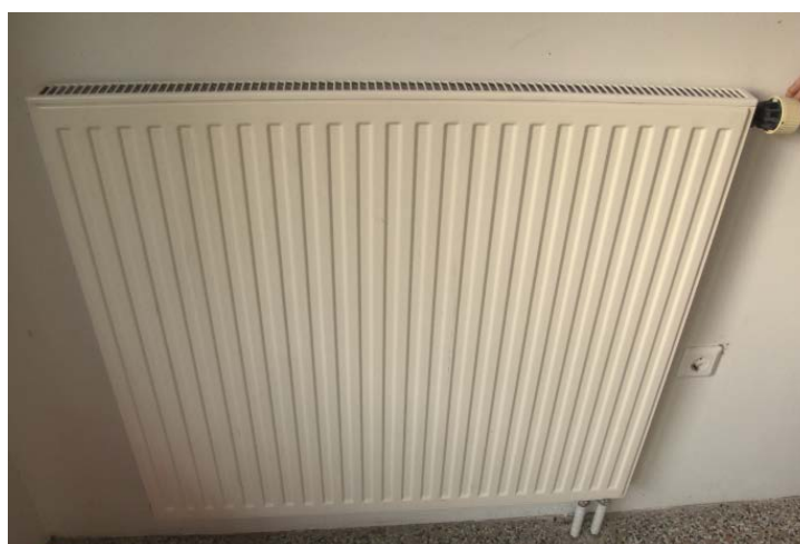
Slika 19: Radiatorsko ogrevanje - nameščeni termostatski ventili
