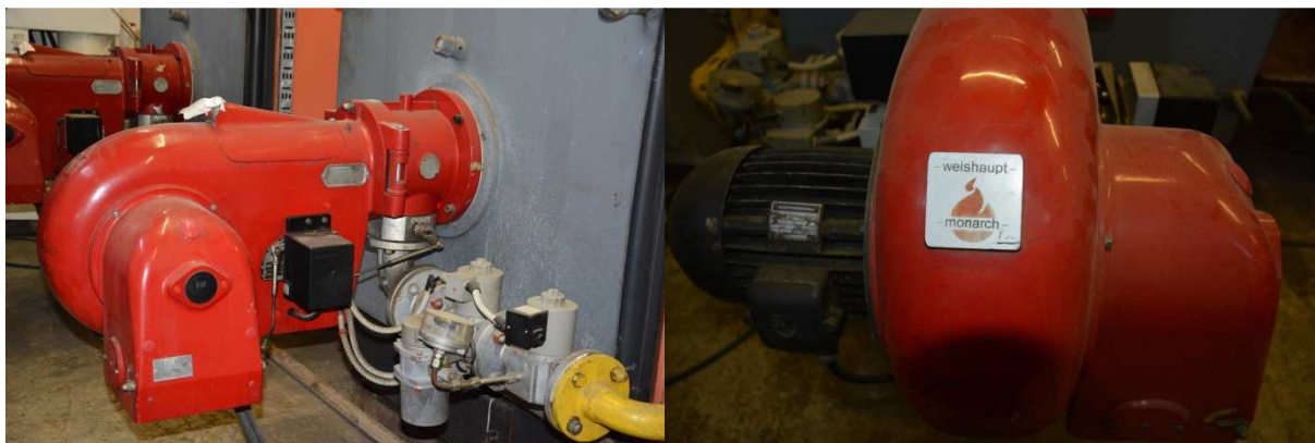
Slika 13: Posnetek gorilnika na zemeljski plin 7
