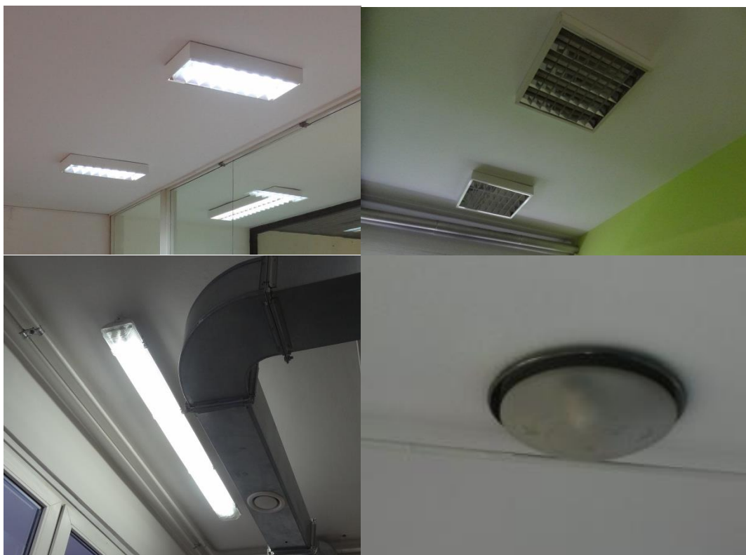
Slika 20: Tipična razsvetljava v vrtcu; (a in b) fluo sijalke z zrcalnim rastrom s klasično predstikalno napravo; (c) prahotesna fluo svetilka; (d) žarnice z žarilno nitko
