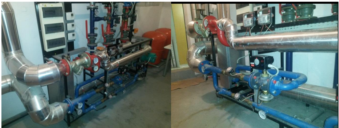
Slika 16: Del razdelilnika ogrevalne toplote; prvi z vgrajenima kalorimetroma, drugi s toplotnim izmenjevalnikom
