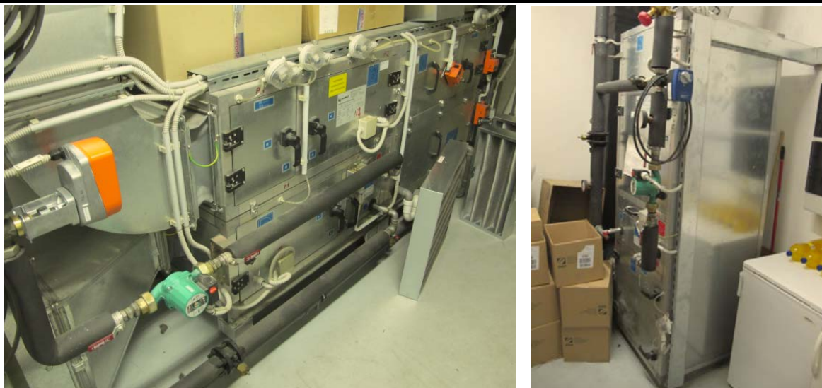
Slika 20: klimat za potrebe telovadnice in kuhinje
