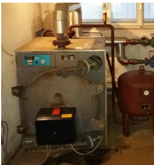
Slika 4: Kotel na ELKO ter razvod ogrevalnega sistema
