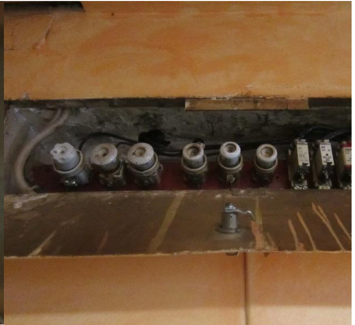
Slika 5.14: Posnetek glavnih varovalk
