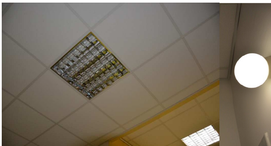
Slika 17: Fluo razsvetljava v prostorih (levo) in luč z žarilno nitko v sanitarijah (desno) 16
