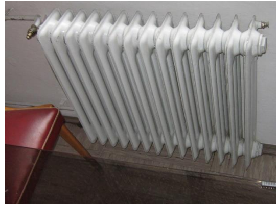
Slika 5.8: Posnetek rebrastega radiatorja EMO TRIKA brez termostatskega ventila
