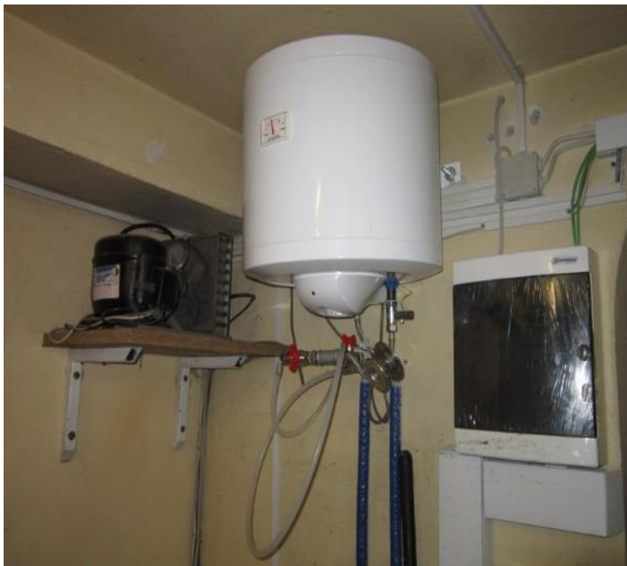
Slika 5.9: Posnetek električnega grelnika sanitarne vode GORENJE TIKI prostornine 50 l – skladišče gostinskega lokala
