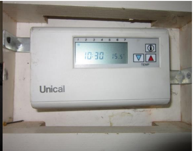
Slika 5.6: Posnetek sobnega korektorja nameščenega v dvorani kulturnega doma Vir: lastni vir.
