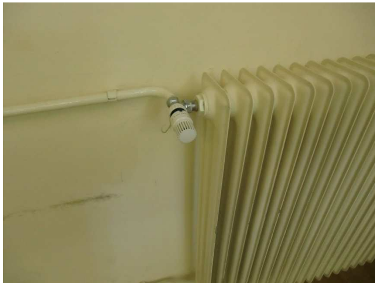
Slika 18: Radiator s termostatskim ventilom 16
