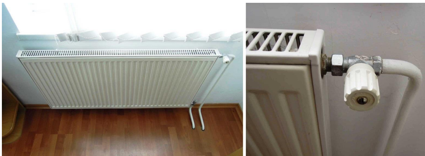
Slika 16: Tipični radiator v objektu (levo) in približan detajl ventila (desno)
