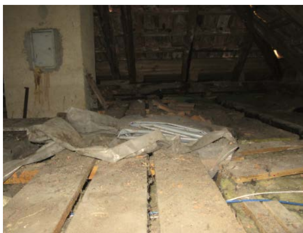
Slika 21: izolirani in neizolirani del podstrešja
