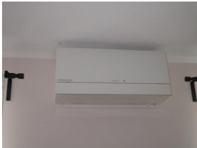
Slika 6.14: Posnetek prezračevalne naprave MITSUBISHI ELECTRIC tip LOSSNAY KAPA
