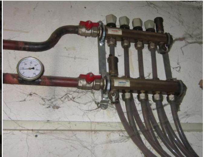
Slika 5.4: Posnetek razdelilnika talnega ogrevanja Vir: lastni vir.
