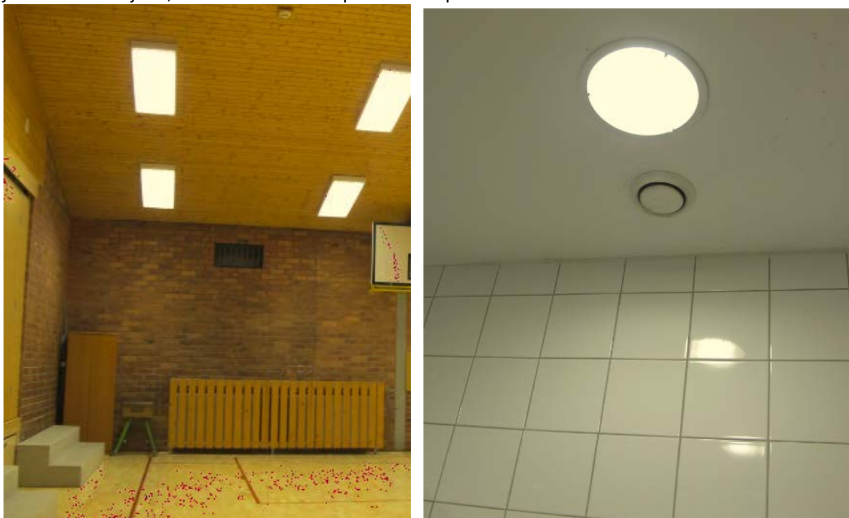
Slika 34: prezračevanje telovadnice (levo), odzračevanje sanitarij (desno)
