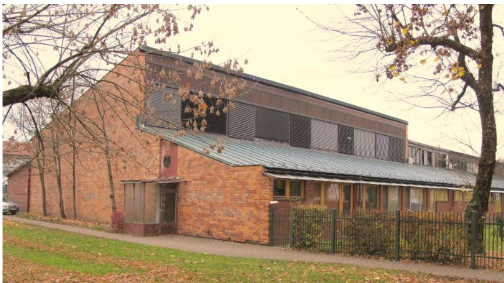
Slika 24: zunanost objekta (bakrena streha, opečna fasada, lesena okna)
