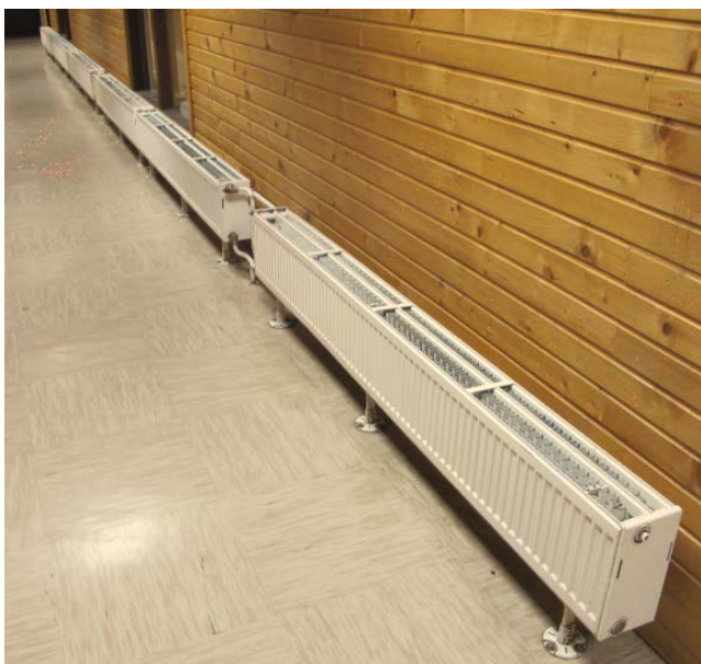
Slika 19: Radiatorsko ogrevanje (levo na hodniku, desno v razredu)
