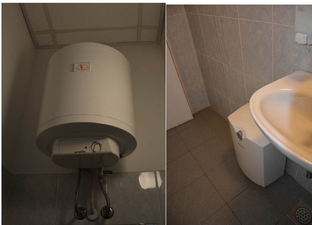
Slika 10: Bojlerja v sanitarijah 7
