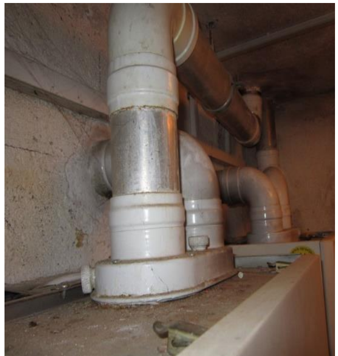
Slika 5.2: Posnetek dimovodnega sistema vrste C52
