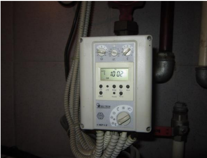
Slika 5.5: Posnetek krmilne regulacijske enote talnega ogrevanja Vir: lastni vir.
