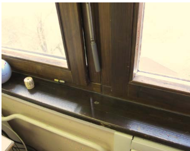
Slika 20: Leseno enojno okno s termopan zasteklitvijo (levo) in leseno škatlasto okno (desno)
