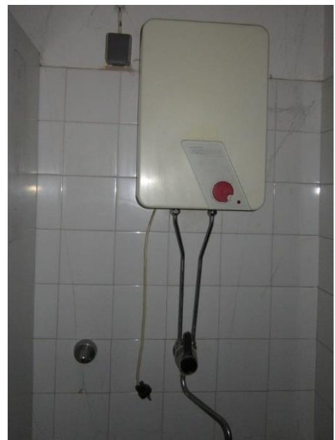
Slika 5.10: Posnetek električnega grelnika vode GORENJE TIKI prostornine 10 l- sanitarije društvenih prostorov
