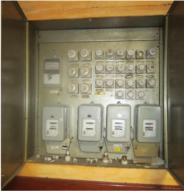
Slika 5.13: Posnetek glavnega elektro razdelilca z merilnogarnituro
