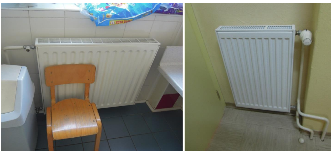
Slika 18: Radiator z navadnim ventilom (levo) in s termostatskim ventilom (desno)
