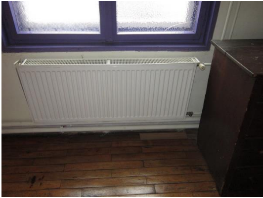
Slika 5.7: Posnetek ploščatega radiatorja VOGEL&NOOT brez termostatskega ventila
