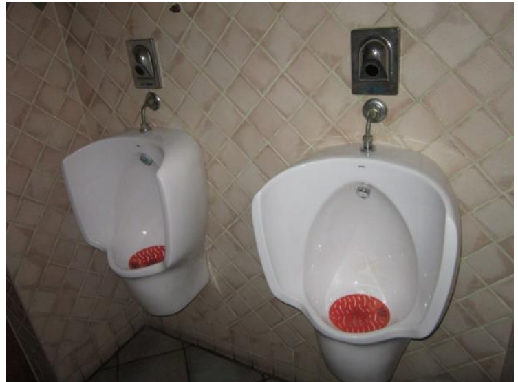
Slika 5.12: Posnetek pisoarjev opremljenih s senzorjem in EMV ventilom
