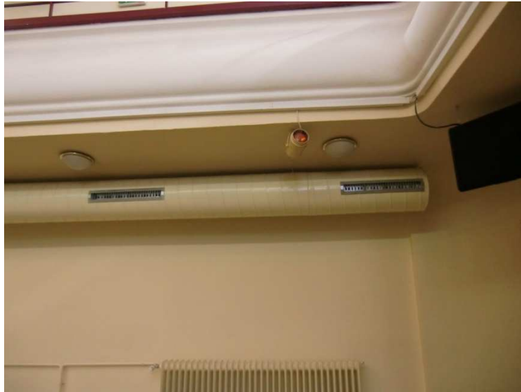
Slika 19: Rešetke za vpih 17
