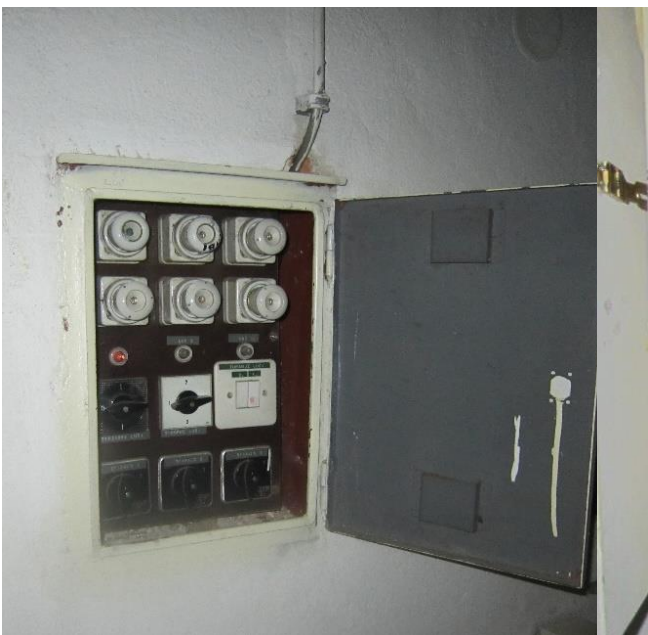
Slika 5.15: Posnetek etažnega razdelilca
