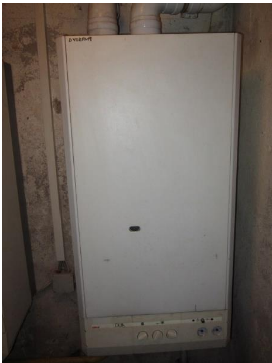
Slika 5.1: Posnetek stenskega plinskega kotla UNICAL DUA RTFS 24 AE
