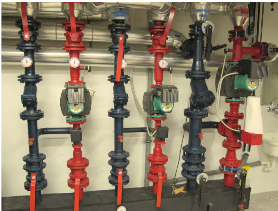
Slika 18: toplotna postaja - razdelilnik
