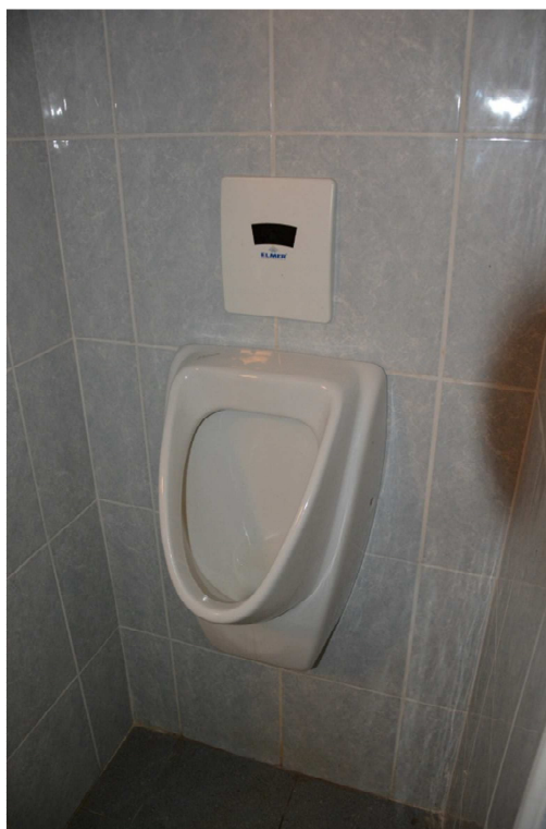
Slika 12: Pisoar s senzorjem 9
