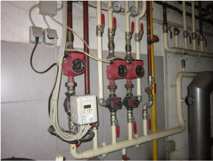
Slika 5.3: Posnetek razdelilnika ogrevanja gostinskega lokala Vir: lastni vir.
