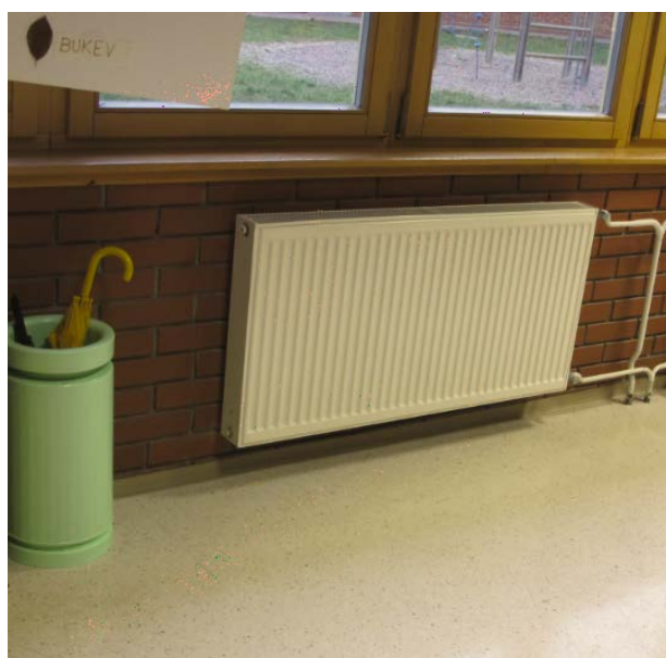
Slika 19: Radiatorsko ogrevanje (levo na hodniku, desno v razredu)
