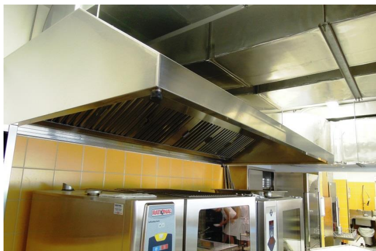
Slika 22: Kuhinjska odvodna napa
