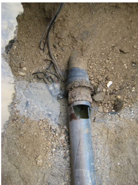
Poškodba cevi ob prelomu in popravilo preloma v križišču Miheličeve ceste in Breznikove ulice
