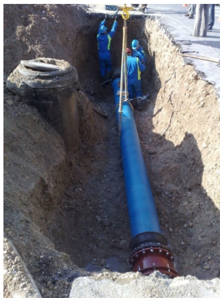
Poškodba cevi ob prelomu in popravilo preloma v križišču Miheličeve ceste in Breznikove ulice
