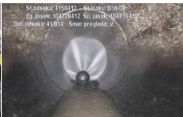
Čiščenje kanala z vodo pod pritiskom
