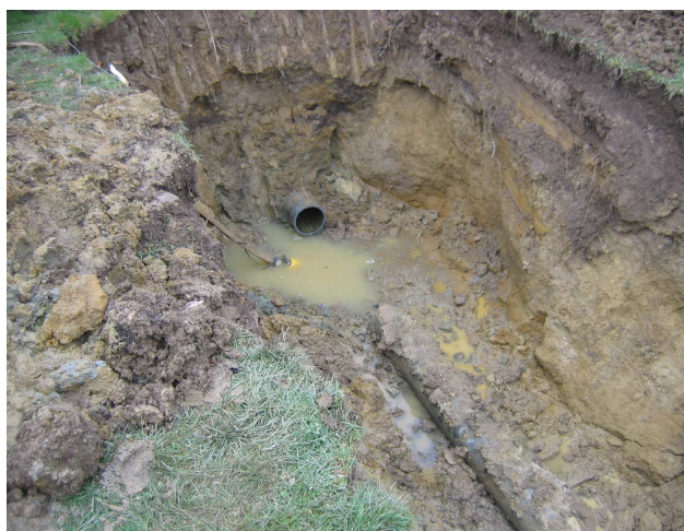
Popravilo preloma cevi na Dolenjski cesti
