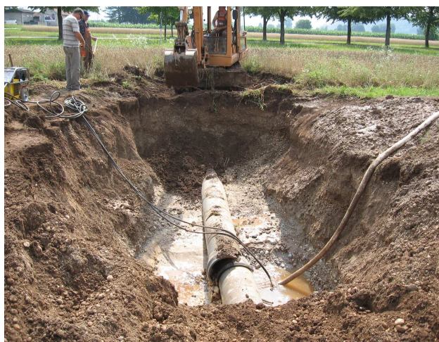
Popravilo preloma cevi na Litijski cesti
