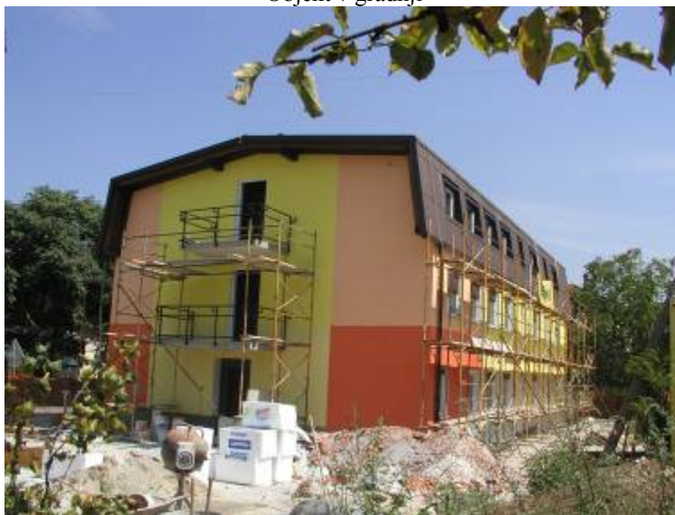
Objekt v gradnji
