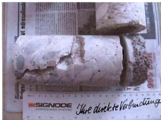
Notranji beton z hidroizolacijo
