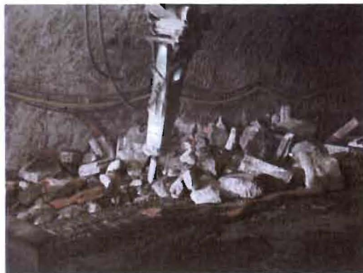
Rušenje obstoječega temelja in kinet
