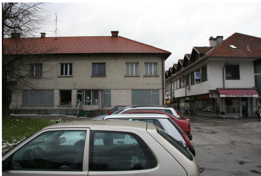
pogled iz Zaloške ceste
