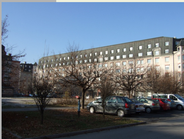
Pogled na blok na Vurnikovi
