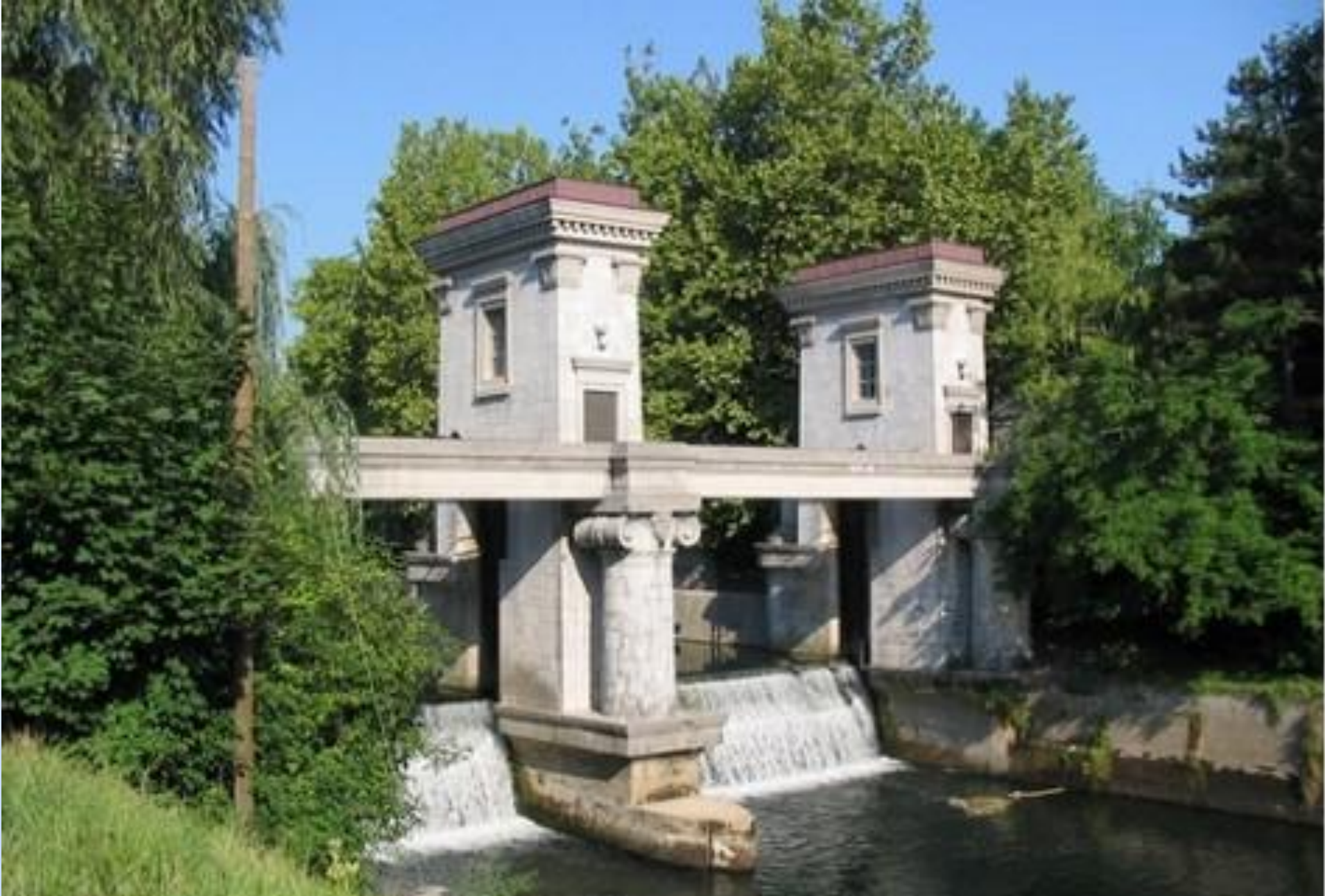
PLEČNIKOVE ZAPORNICE – BRANIK PRED POPLAVAMI
