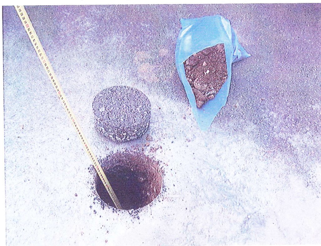
Slika 5: Odvzem vrtine asfaltne utrditve in vzorca nevezane nosilne plasti pod njo
