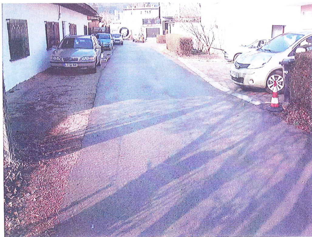
Slika 3: Pogled na stanje ulice Bratov Židan v smeri proti železnici
