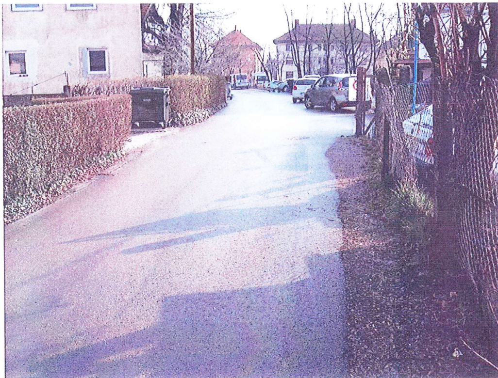
Slika 2: Pogled na stanje ulice Bratov Židan v smeri proti Parmovi ulici
