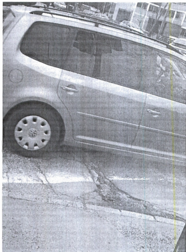
Slika 4: Poškodbe na križišču Pesarske
