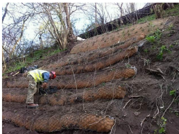
Utrjevanje brežine ob poti Za ovinki na mestu porušenega drevesa z BVS strukturno mrežo z vegetacijskimi pasovi.
