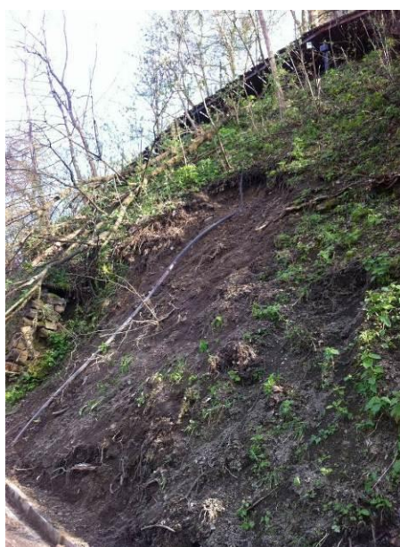
Manj strme brežine, kjer je utrditev manj potrebna, se je izravnalo in proti-erozijsko zaščitilo s senenim nastiljem.
