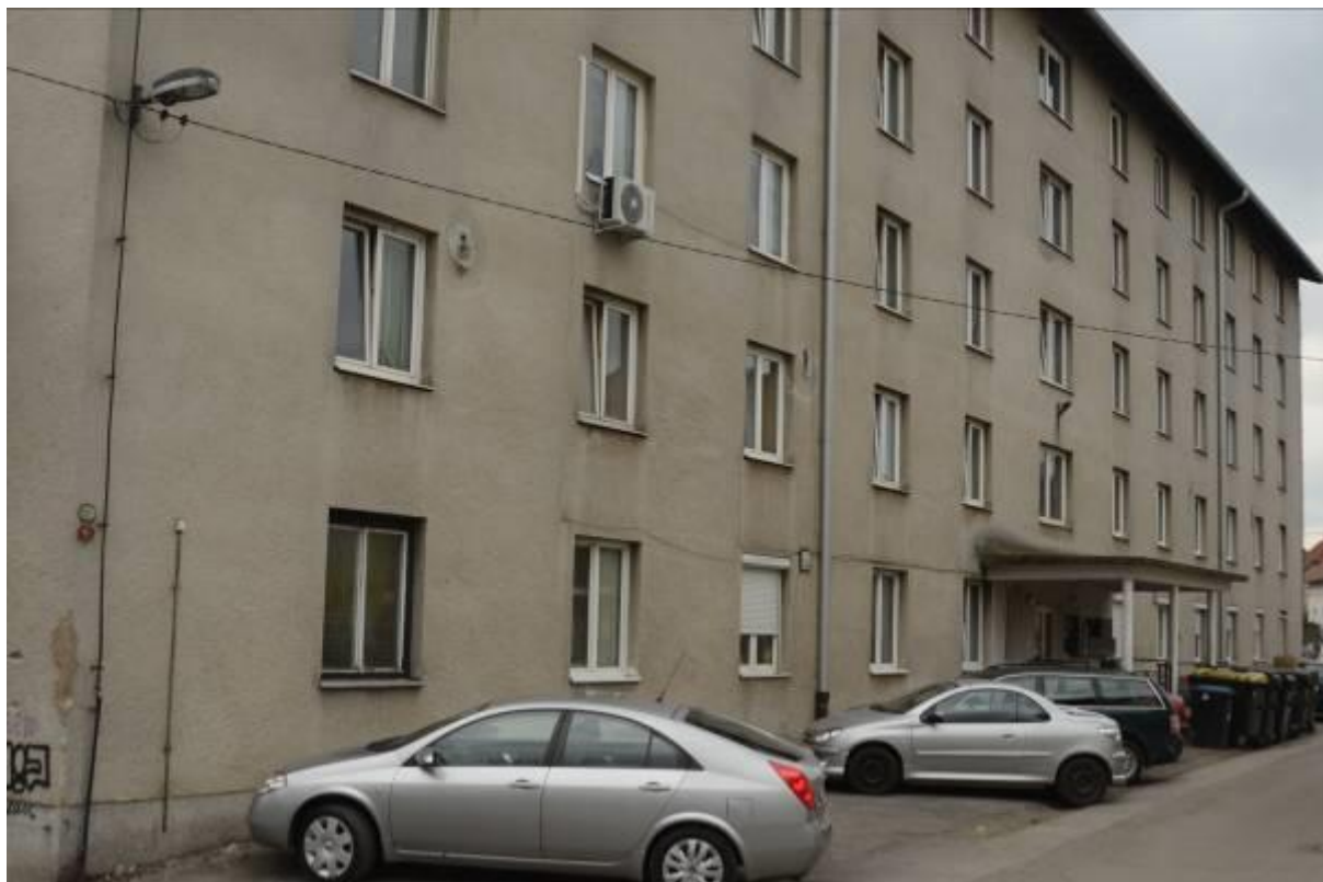
slika: objekt samski dom Vide Pregarčeve 34
