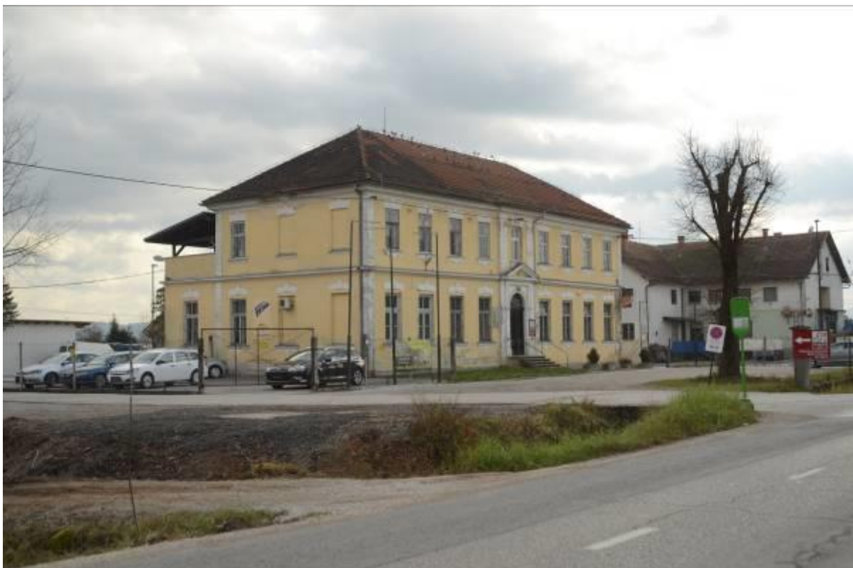
lokacija Ižanska 303 – obstoječi objekti
