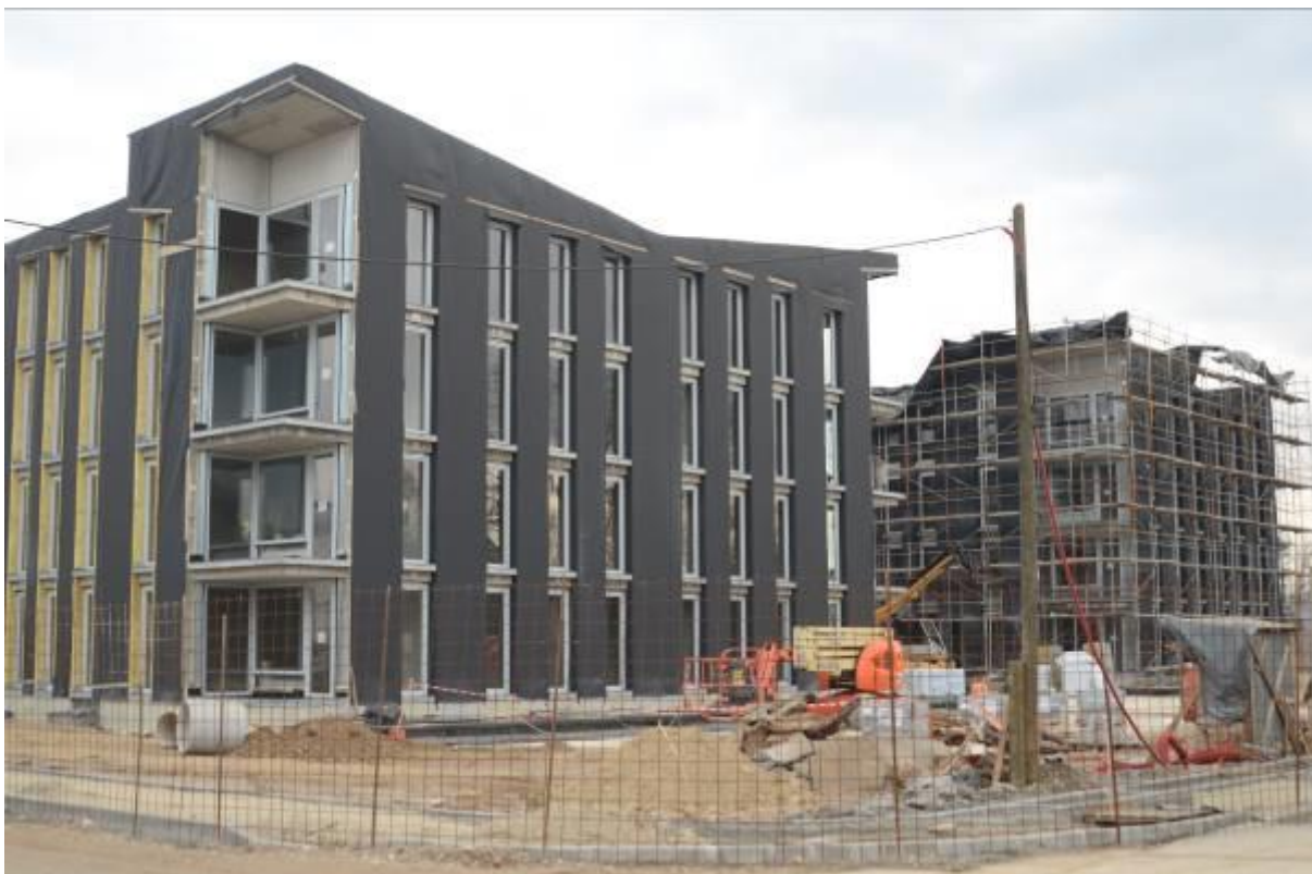
stanovanjska soseska Polj III v izgradnji
