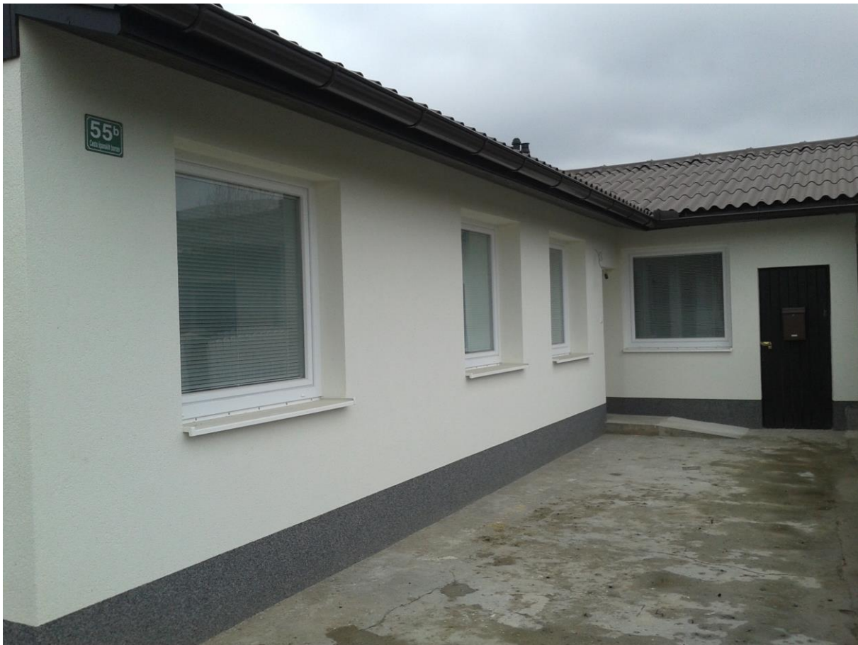
prenovljena stanovanjska enota v naselju Cesta španskih borcev
