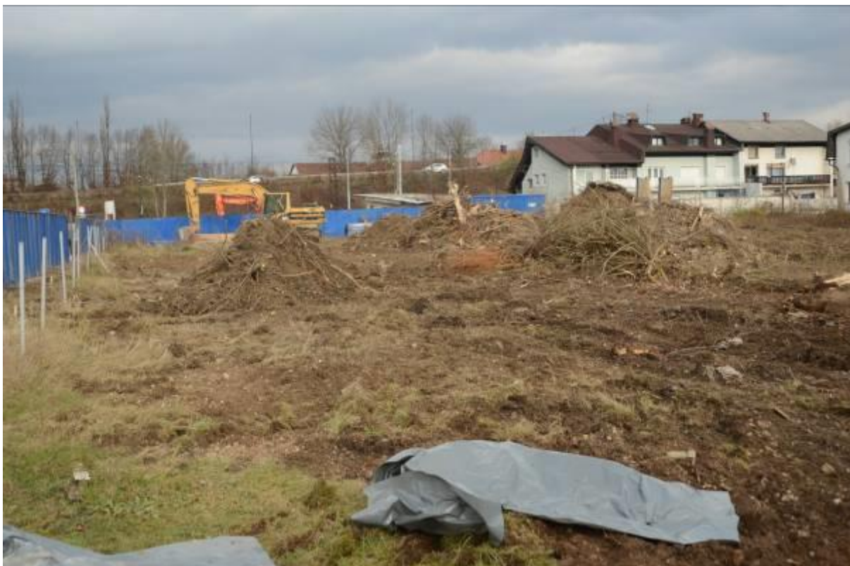
stanovanjska soseska Dolgi most po predaji gradbišča izvajalcu gradbenih del
