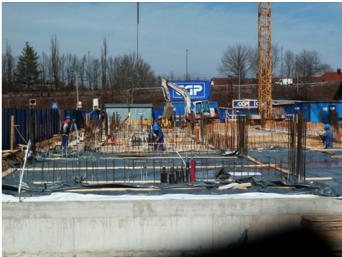
slika: soseska Dolgi most v izgradnji
