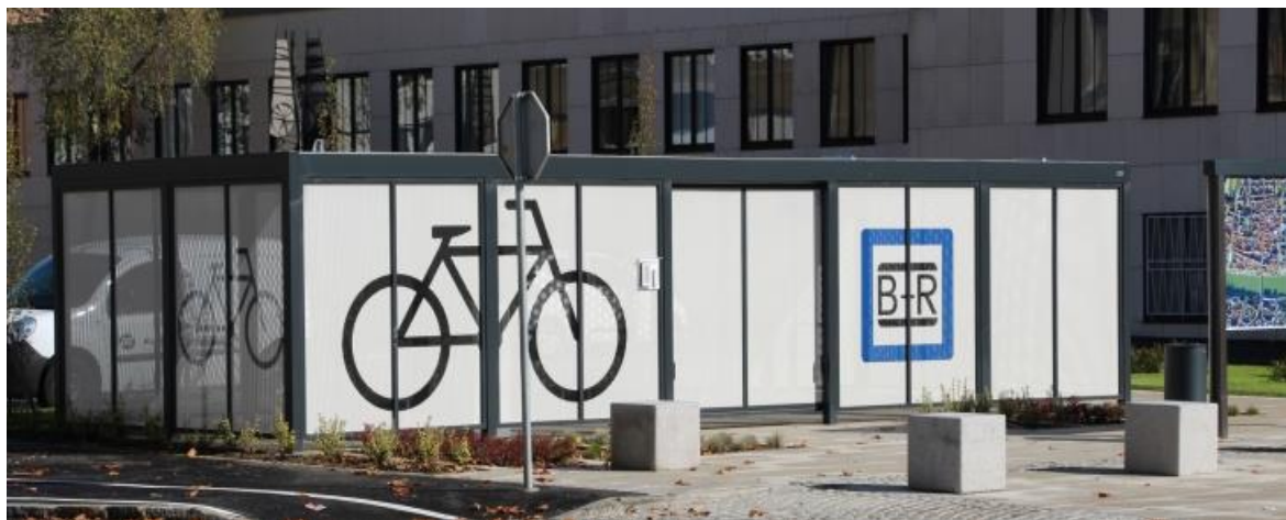
Foto: Kolesodvor - varovana kolesarnica, pred železniško postajo v Mariboru
