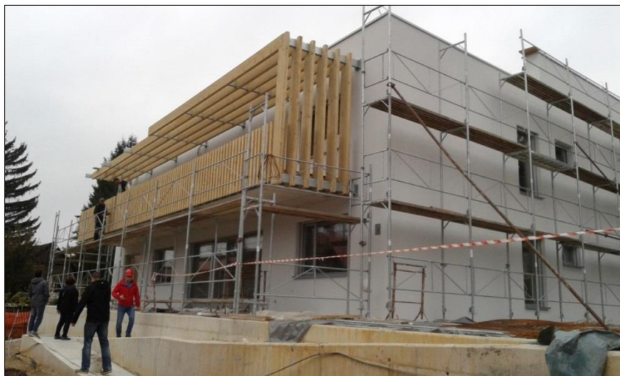
Fotografija objekta Vinčarjeva med gradnjo
