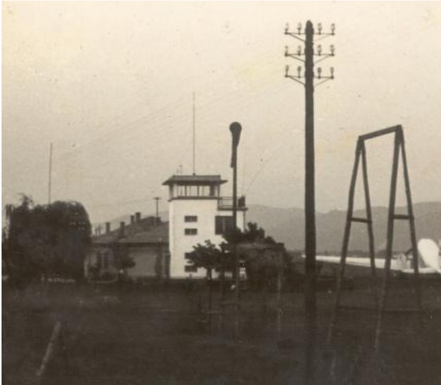
Slika 7: Kontrolni stolp nekoč
