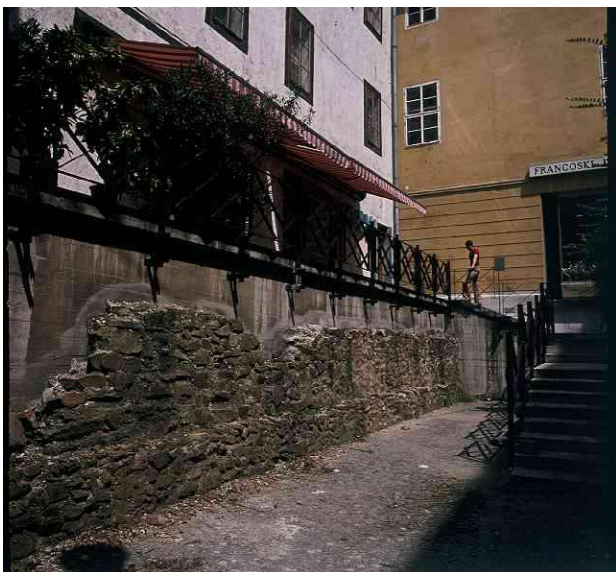
Slika 13: Severno emonsko obzidje v ulici Josipine Turnograjske: del ohranjenega zidu v pročelju uršulinskega samostana. Foto dokumentacija MGML.
