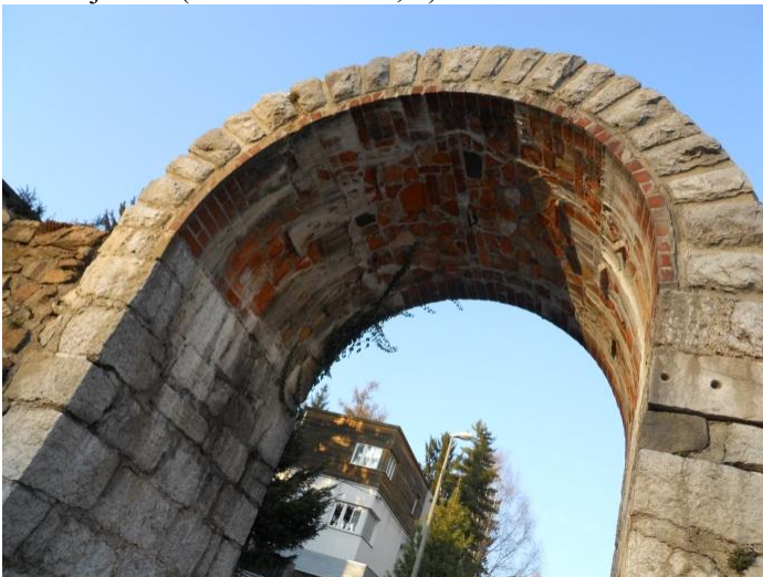
Slika 41: Rimski zid. Zahodni prehod. Siga in kristalizacija soli na notranji strani oboka. Stanje na dan 11. 1. 2013. . Foto Matjaž Bizjak.
