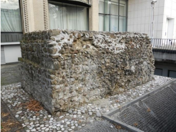
Slika 50: Zahodno emonsko obzidje ob Cankarjevem domu. Vidna je recentno nanešena malta. Stanje na dan 3. 1. 2013. Foto Matjaž Bizjak.
