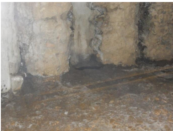
Slika 57: Pločnik rimske ceste v Chopinovem prehodu (»i-Emona«). Zamakanje in posledično kristalizacija soli na površini. Stanje na dan 3. 1. 2013. Foto Matjaž Bizjak.
