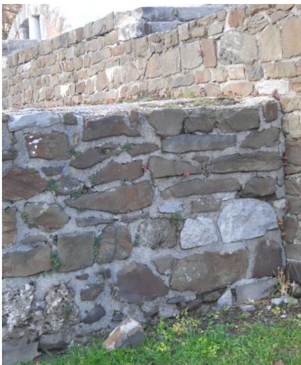
Slika 43: Rimski zid. Odkrušen kamen na obnovljenem delu. Stanje na dan 11. 1. 2013. . Foto Matjaž Bizjak.
