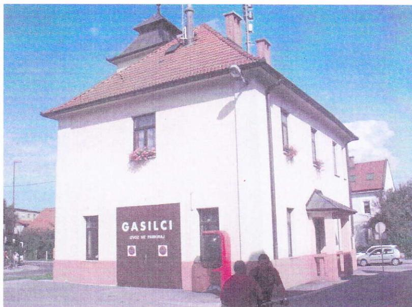
SPLOŠNO: Objekt je bil zgrajen v letu 1928. Tloris objekta je pravokoten, dimenzij 12,90 m x 9,70 m, z razširitvijo na mestu stolpa 0,75 m x 3,00 m. Obsega pritličje nadstropje in neizkoriščeno podstrešje. Višini etaž znašata 3,80 m v pritličju in 2,85 m v nadstropju, zidovje stolpa pa je visoko cca. 10,50 m.
