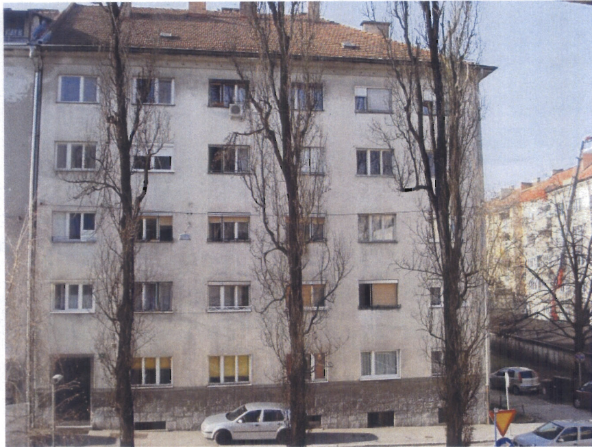
Slika: Obstoječi objekt Zarnikova 4
