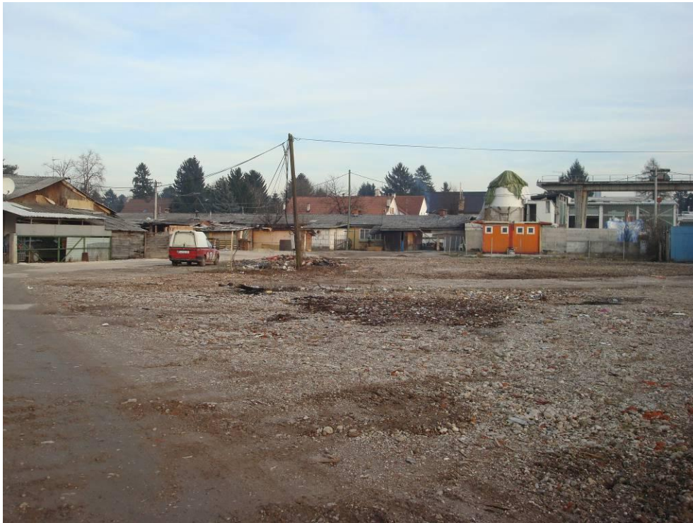
Slika: preostali del barakarskega naselja, ki ga je potrebno še porušiti
