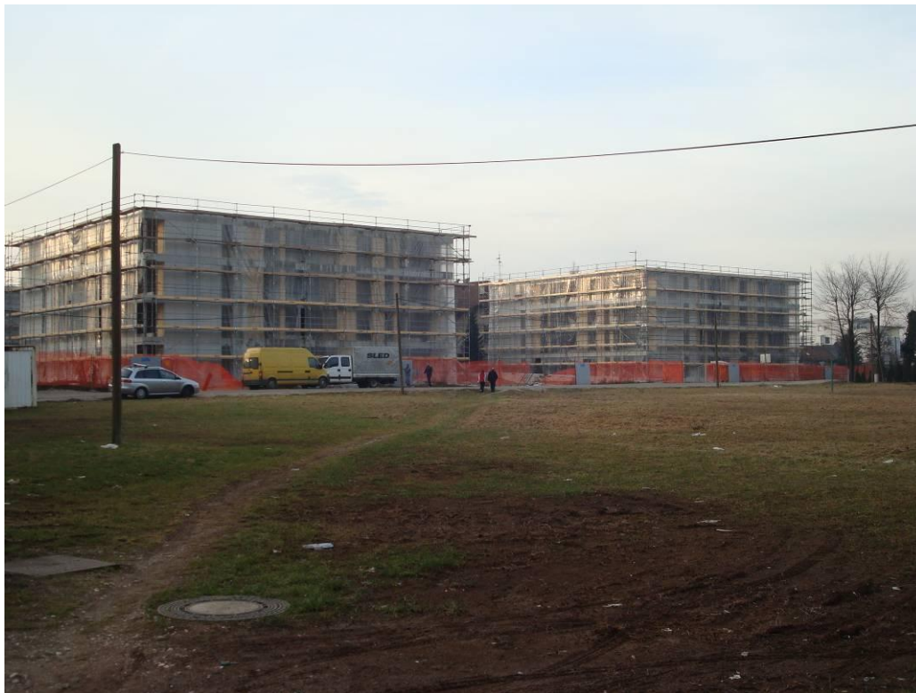
Slika: soseska v gradnji
