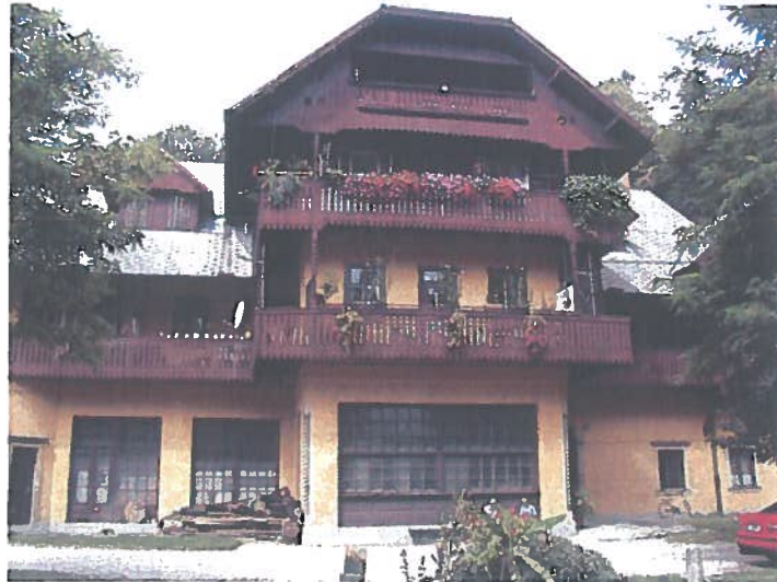
slika: objekt Pod Turnom 4
