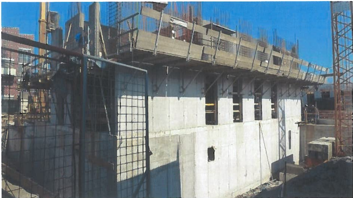
Slika: Stanovanjska soseska Polje III v gradnji
