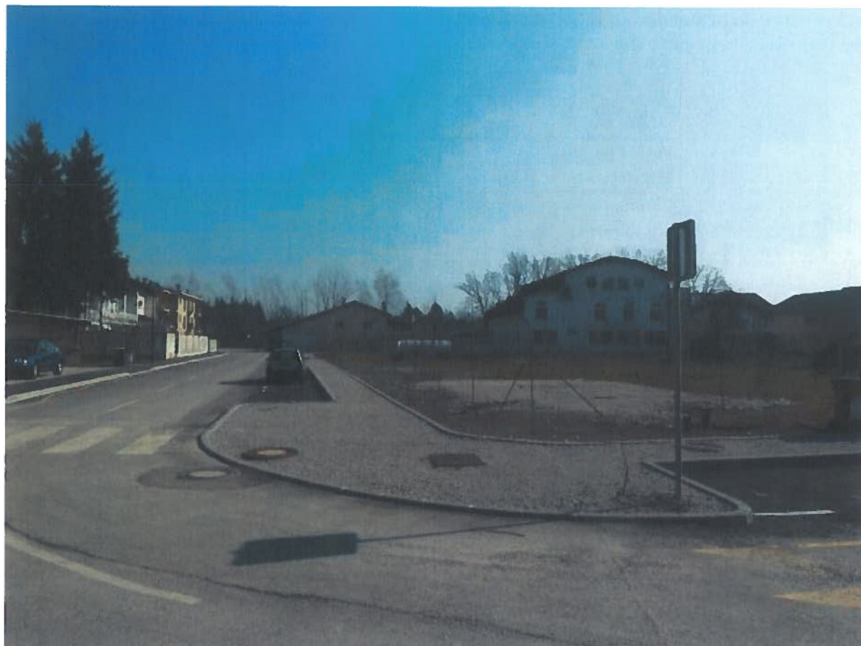
Slika: Komunalno in prometno urejeno zemljišče, kjer bo zgrajena stanovanjska soseska Dolgi most
