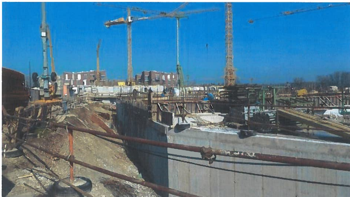
Slika: Stanovanjska soseska Polje III v gradnji
