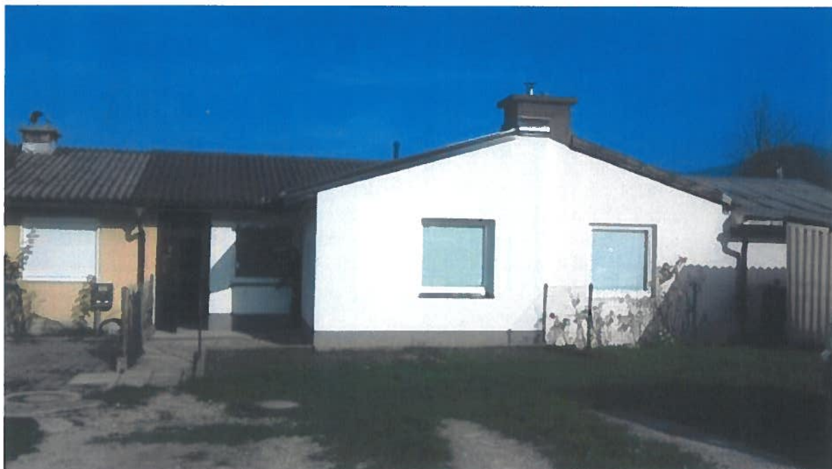
Slika: Eden izmed prenovljenih objektov v naselju Cesta Španskih borcev
