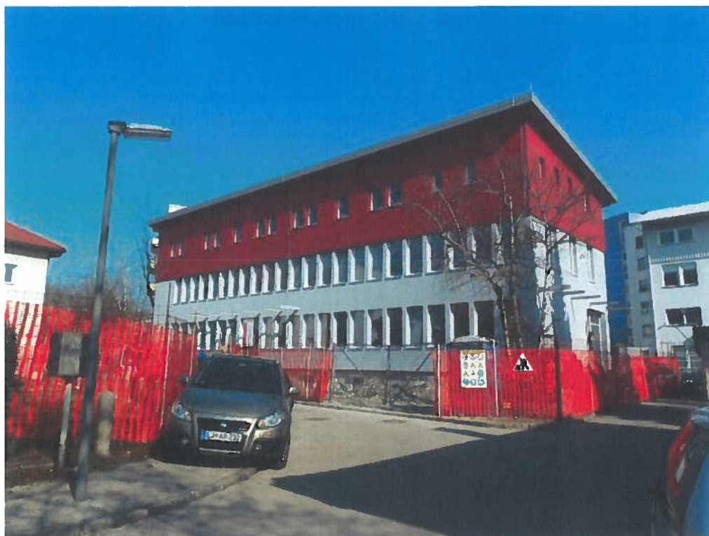
Slika: Že prenovljena fasada objekta Belokranjska 2
