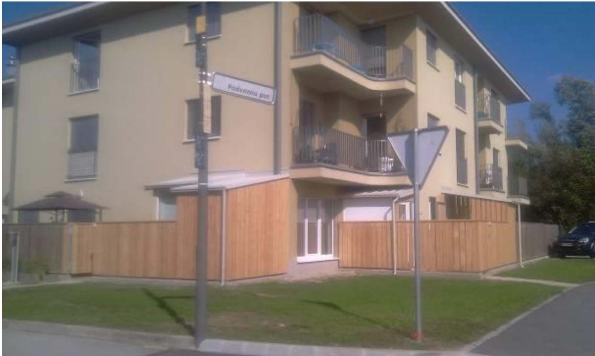
slika: bivalni enoti v pritličju, ki sta prenovljeni iz poslovnega prostora
