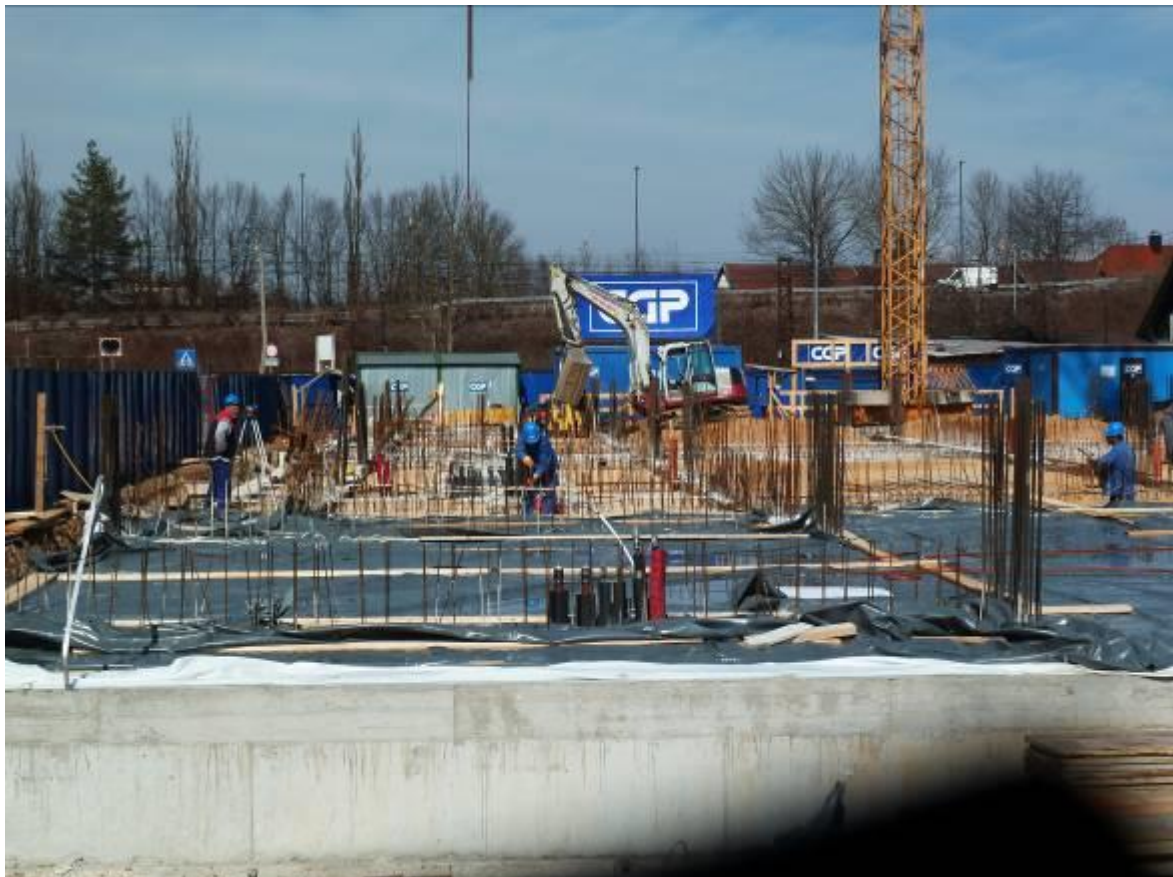
slika: soseska Dolgi most v izgradnji
