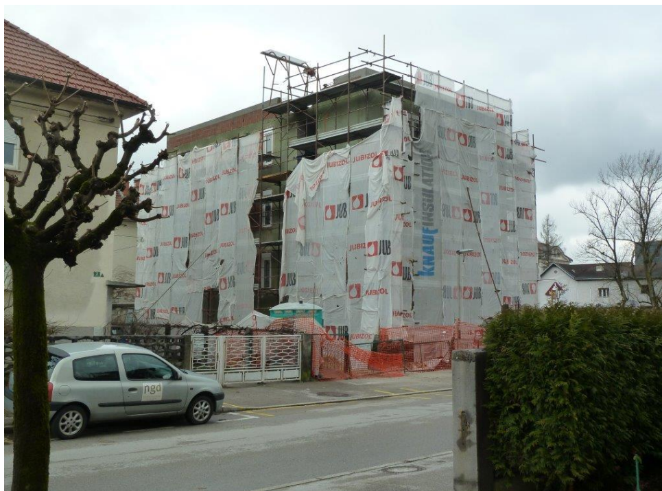
Fotografija: Izvajanje del na objektu »Ob Ljubljani 42«
