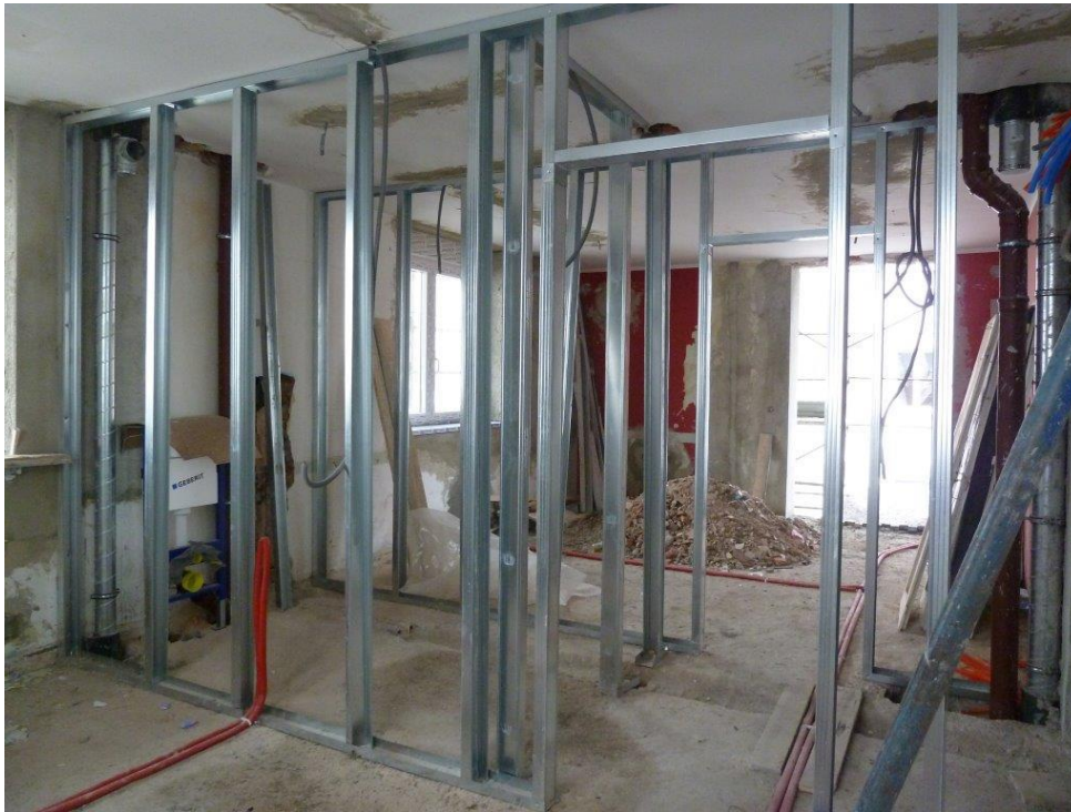
Fotografija: Rekonstrukcijska dela za spremembo namembnosti v notranjosti objekta
