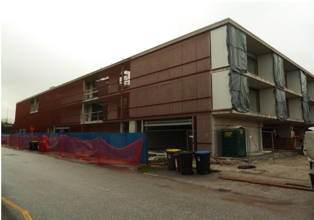
Fotografija: Izvajanje del na objektih »Dolgi most«
