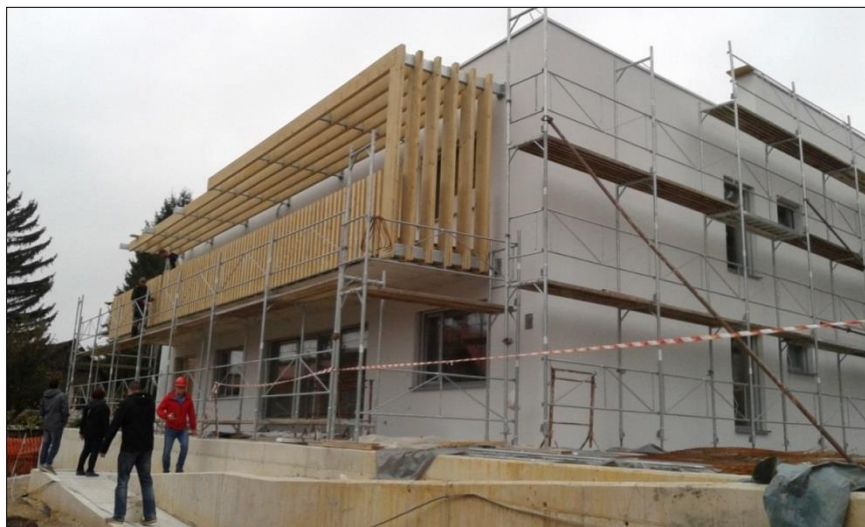
Fotografija objekta Vinčarjeva med gradnjo
