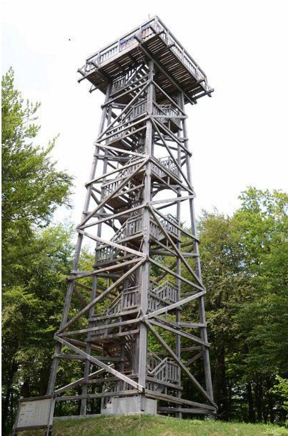
Slika 5: Razgledni stolp na Ulovki, detajl konstrukcije stolpa s polžastimi stopnicami
