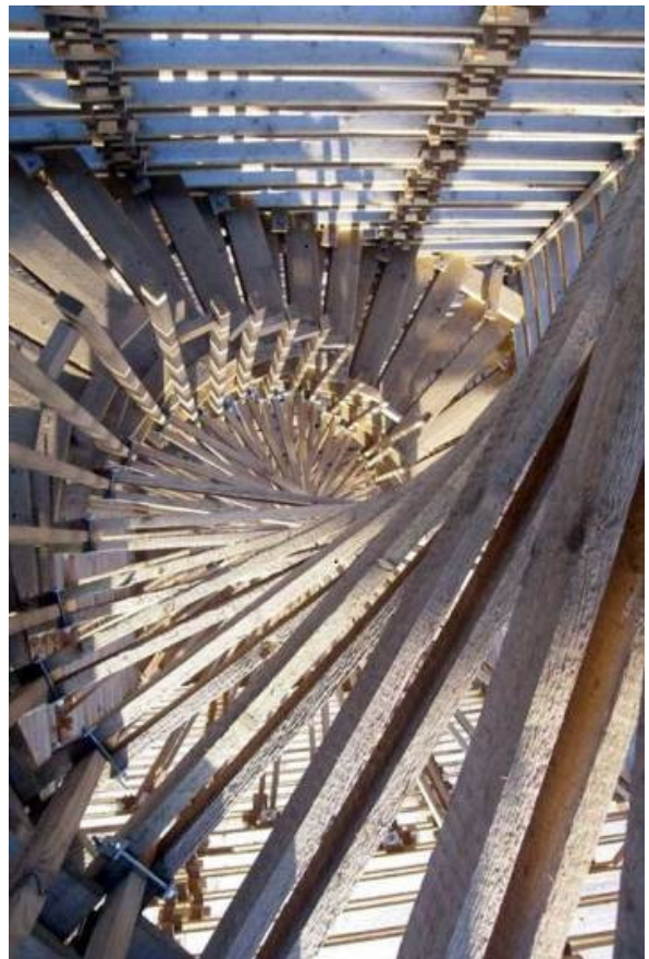
Slika 5: Razgledni stolp na Ulovki, detajl konstrukcije stolpa s polžastimi stopnicami
