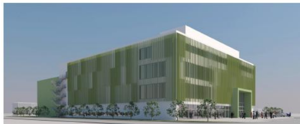
DVORANA ZA GIMNASTIKO (STAVBA A) – pogled z JZ strani
