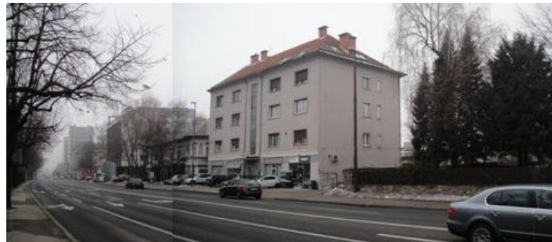
Pogled na obstoječi stanovanjski blok
