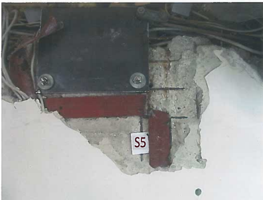
Slika 5: Sonda na mestu vpetja stebra S5
