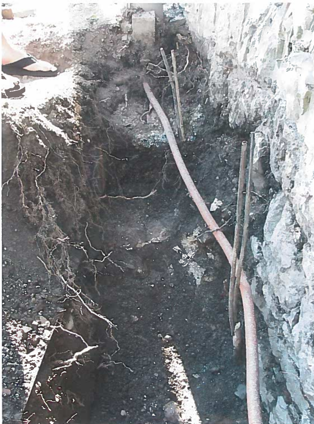
Slika 5: Sondažni izkop SI-5
