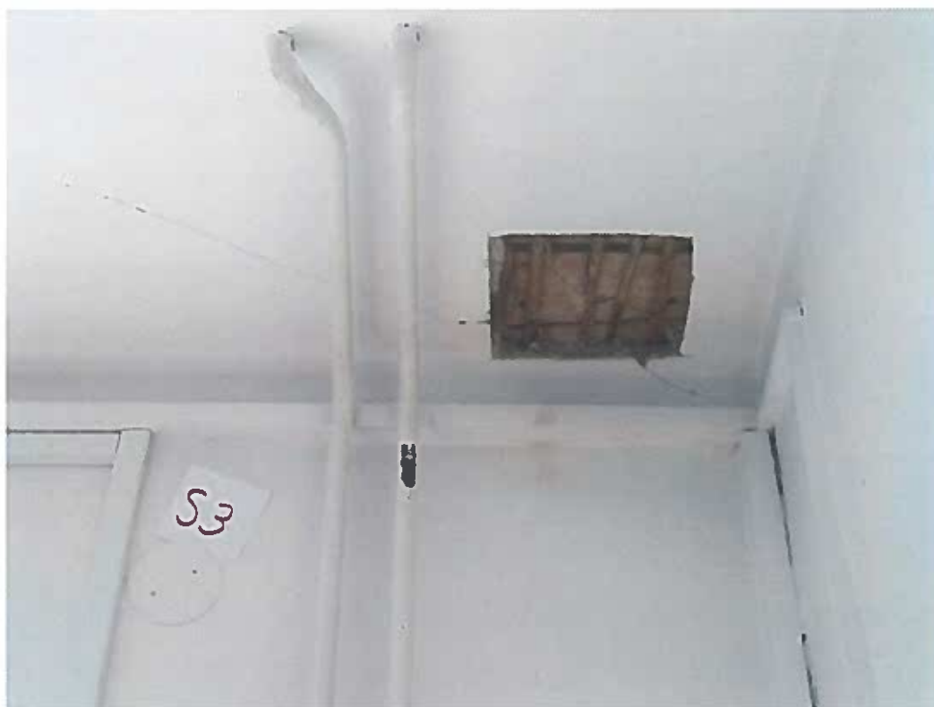
Slika 7: Sonda na mestu vpetja stebra S3
