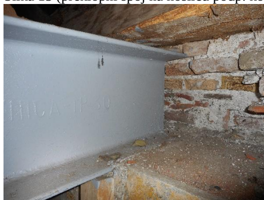
Slika 15 (detajl pritrditve podp. konst.)
