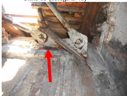
Slika 21 (pritrditev zatega Z7.1)
