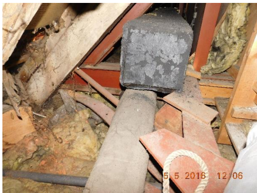
Slika 32 (podporna konstr. za sidro Z8.3)
