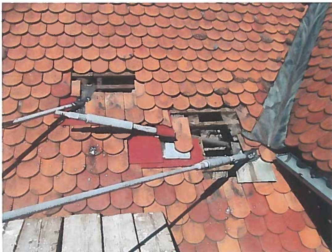
Slika 12: Zunanji sondi na mestu sidrišč B4 in B5
