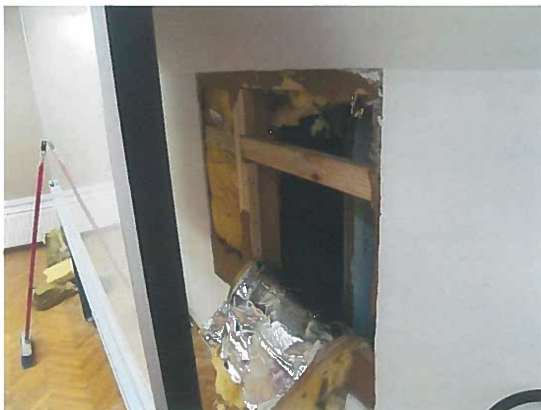
Slika 8: Sonda na mestu vpetja stebra S6
