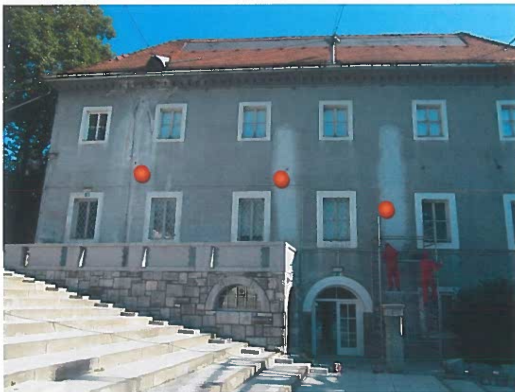
Slika 1: Mesta izvedbe zidnih sond
