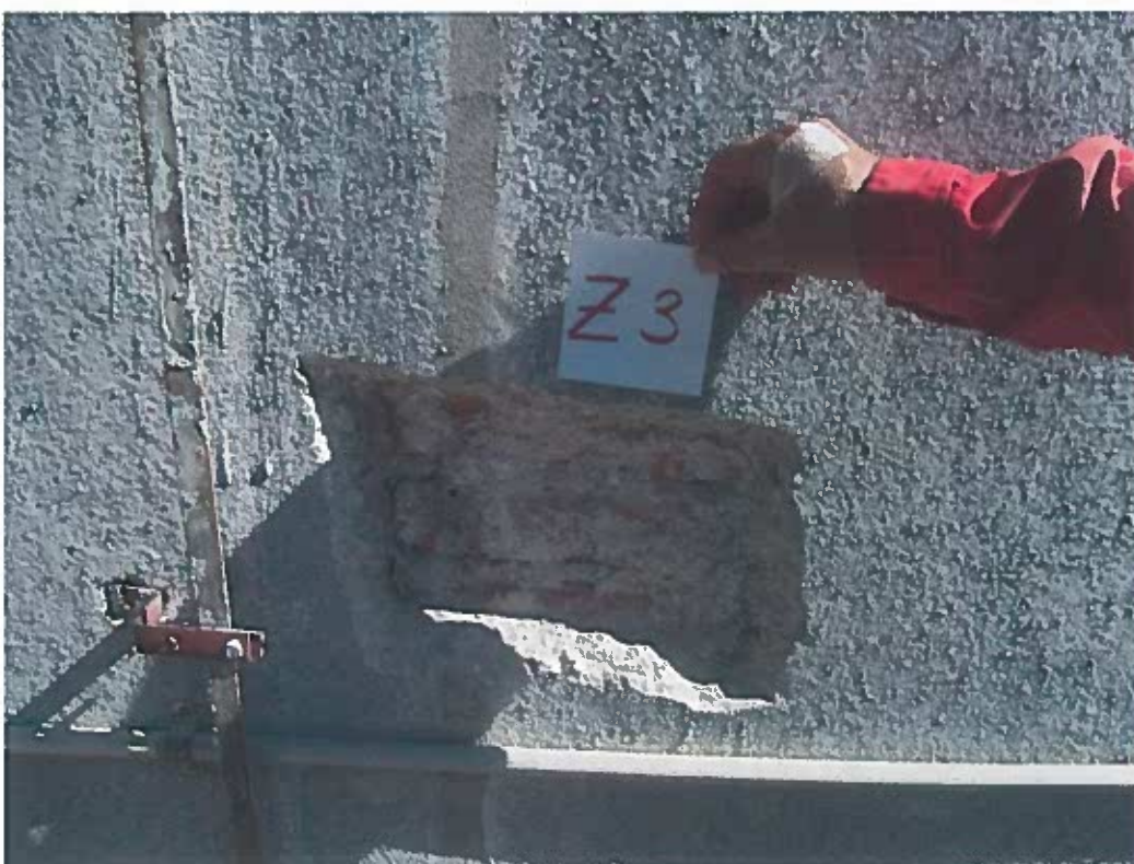
Slika 4: Zidna sonda Z3
