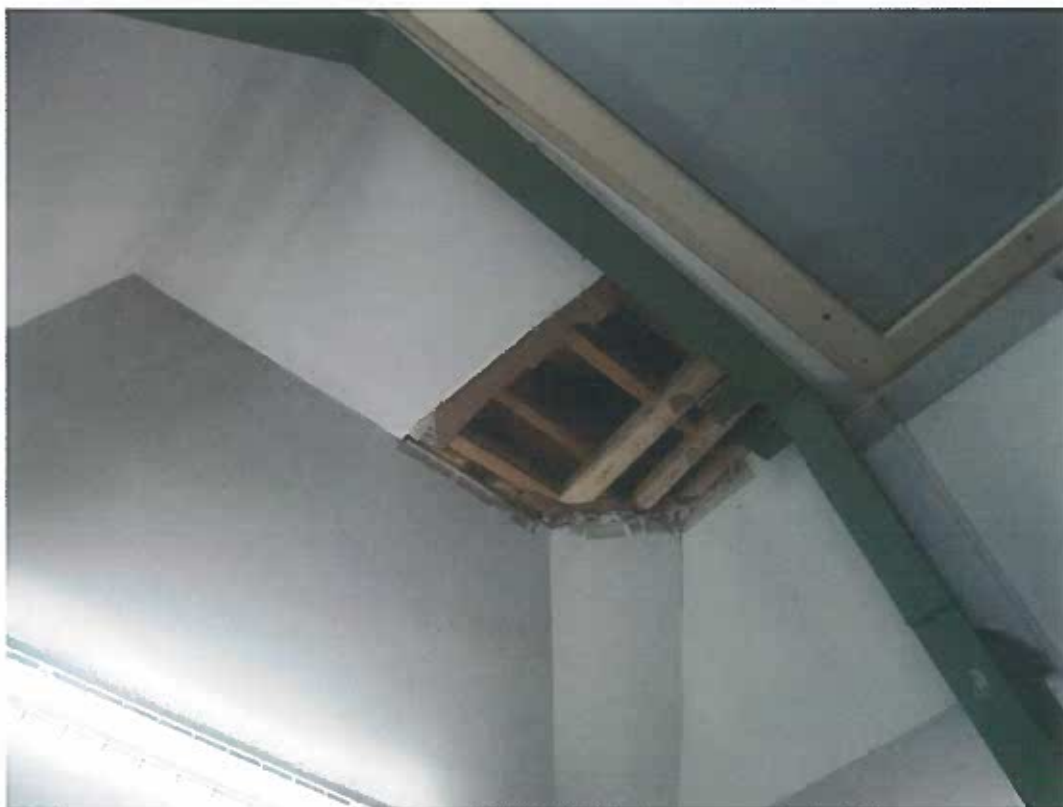
Slika 10: Sonda na mestu sidrišča natezne palice S6
