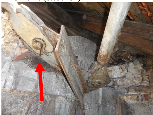
Slika 20 (pritrditev zatega Z7.1)
