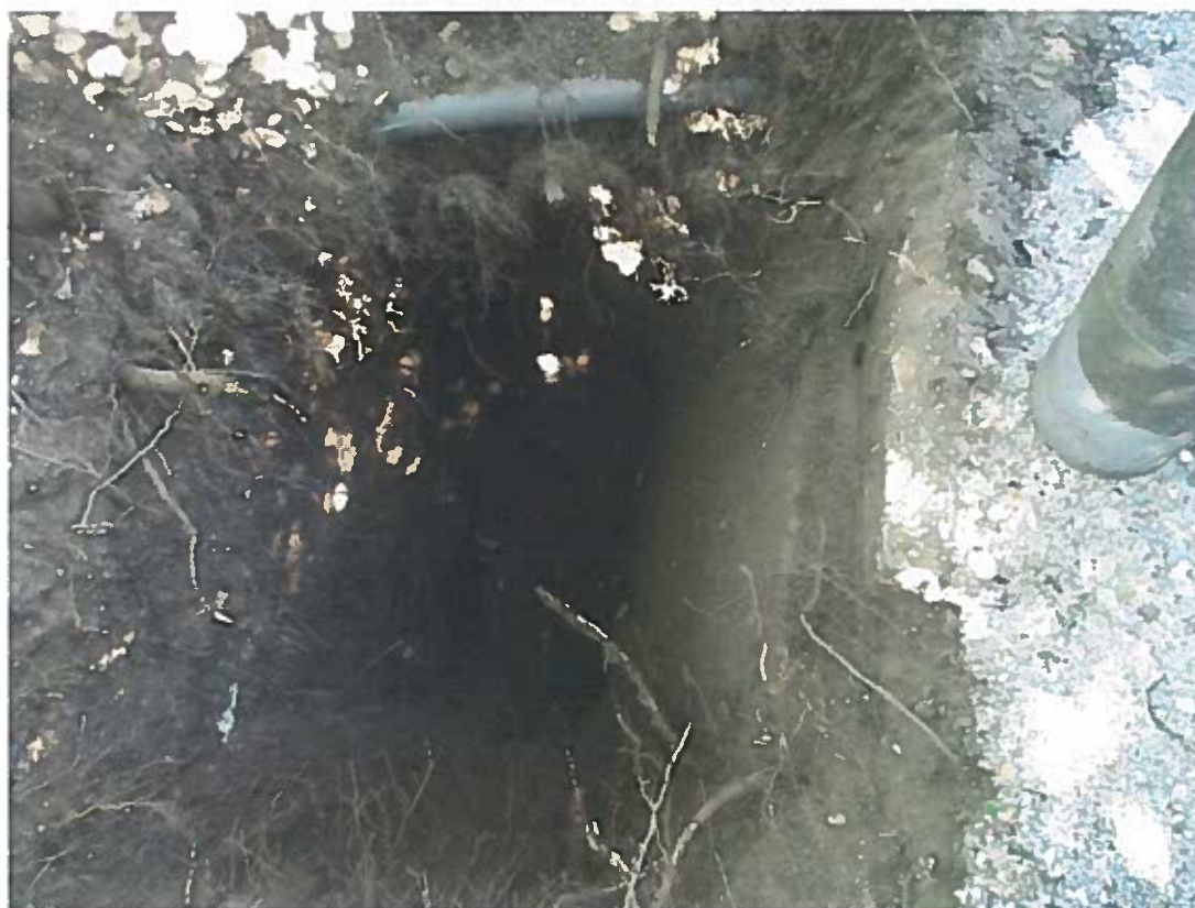
Slika 4: Sondažni izkop SI-4
