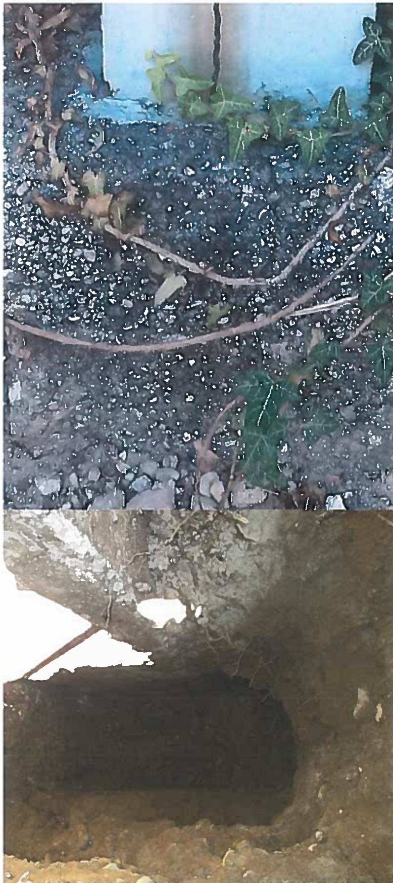
Slika 2: Sondažni izkop SI-2
