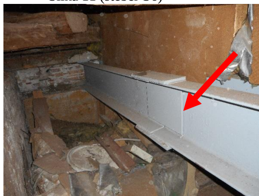
Slika 13 (preklopni spoj na nosilec podp. konst.)
