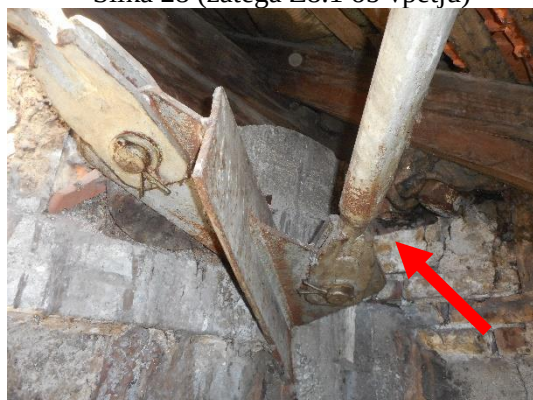
Slika 30 (pritrditev zatega Z8.2)
