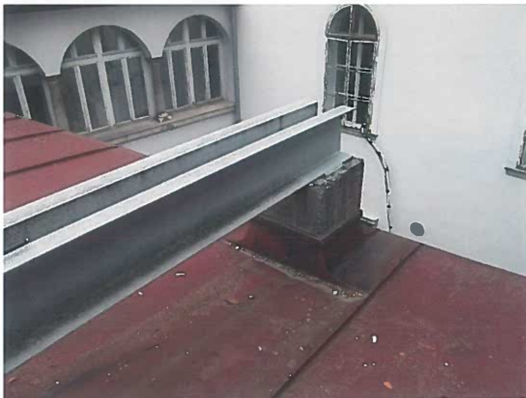
Slika 13: Betonski temelj sidrišča S8
