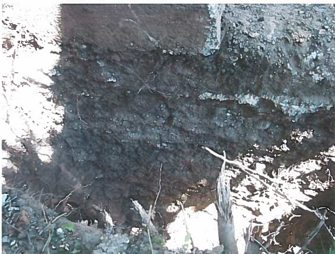
Slika 1: Sondažni izkop SI-1
