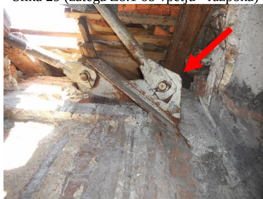
Slika 31 (pritrditev zatega Z8.2)
