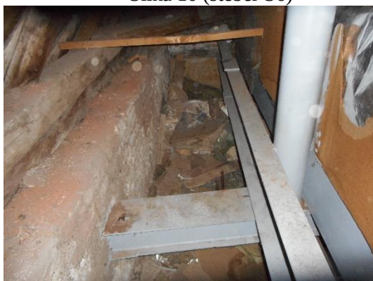
Slika 12 (jeklena podp. konst. za steber S6)
