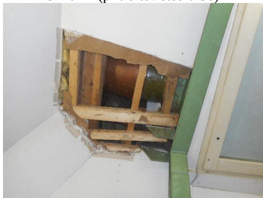
Slika 16 (podporna konstr. za sidro Z6.1)
