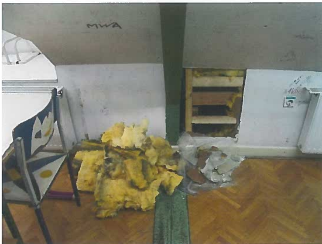
Slika 11: Notranja sonda na mestu sidrišč B4 in B5
