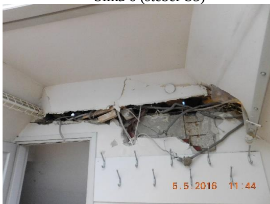
Slika 8 (AB podp. konstr. za zatego Z5.1)
