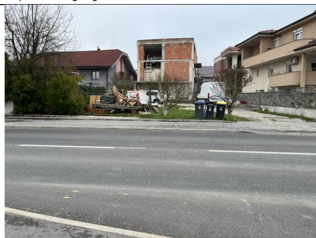
Slika 6: Pogled na območje LP; Vir: arhiv LUZ
