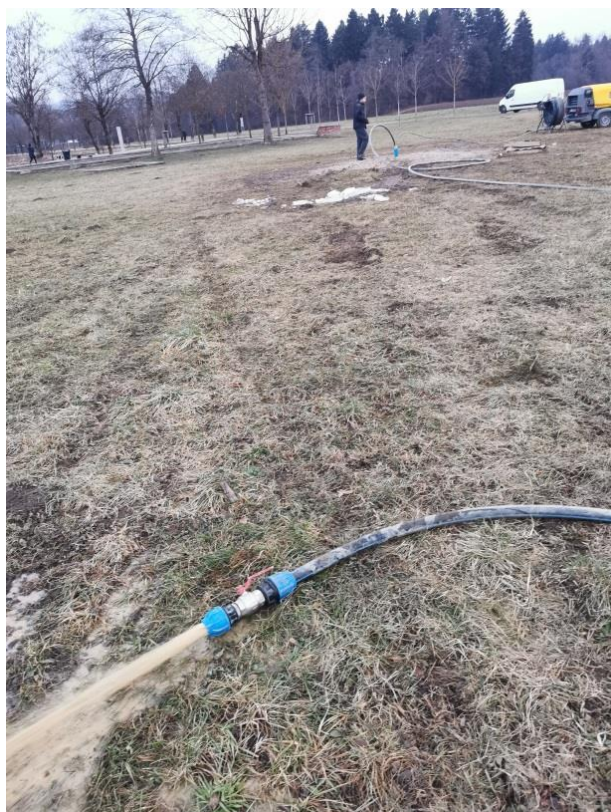
Slika 4 Aktivacija piezometra FFA-P2.
