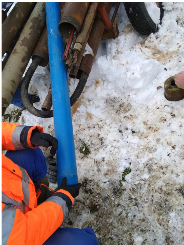
Slika 13: Cevitev vrtine P-2/21 s PVC cevmi, na dnu je čep s konico, nato je 1 m dolga polna cev-usedalnik
