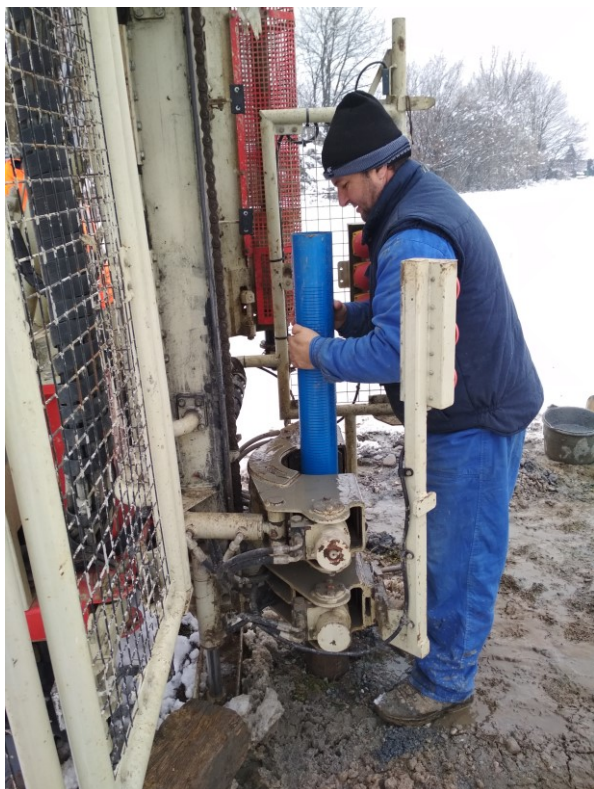
Slika 6: Cevitev vrtine P-1/21 s PVC cevmi.
