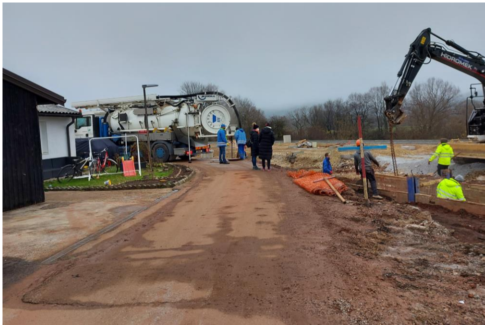
Izvajanje del za rekonstrukcijo obstoječe javne prometne, komunalne in energetske infrastrukture in skupnih delov soseske (foto JSS MOL, december 2020)
