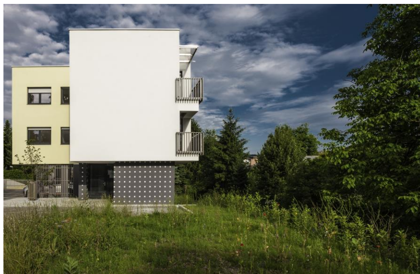
Stanovanjska stavba Pečinska 2 pred vselitvijo stanovalcev (foto avgust 2020)
