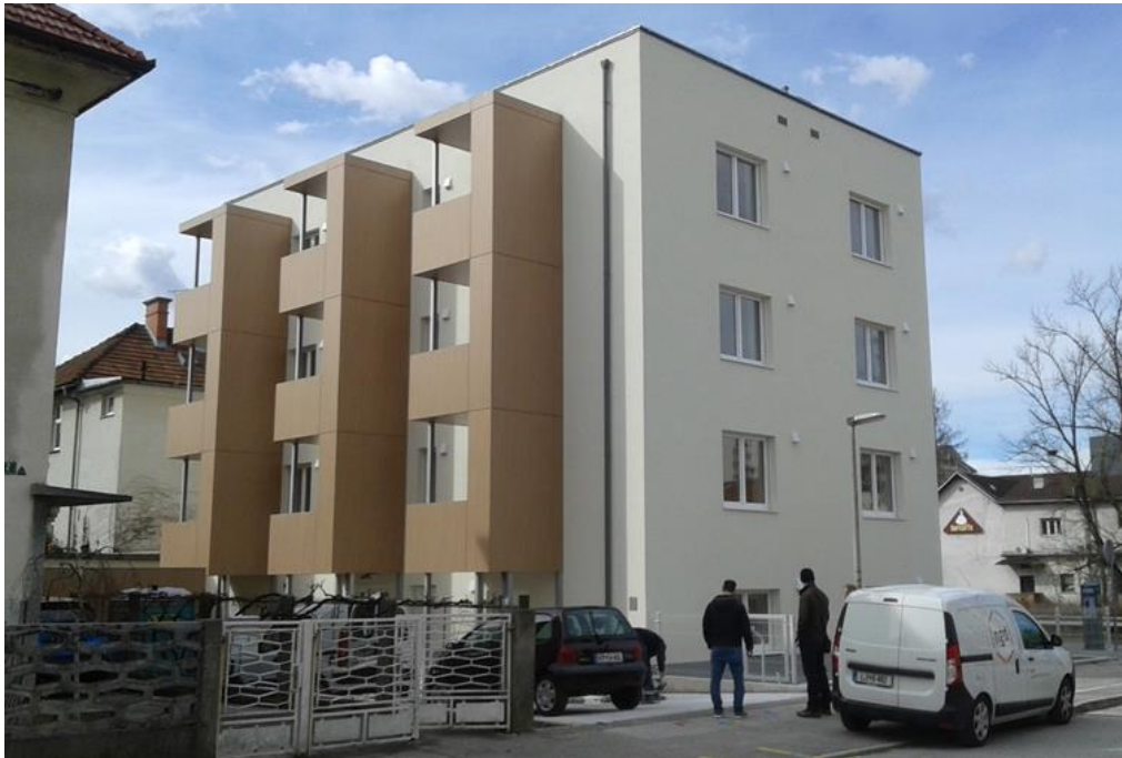
Fotografija: Stavba Ob Ljubljani 42 v zaključni fazi rekonstrukcije
