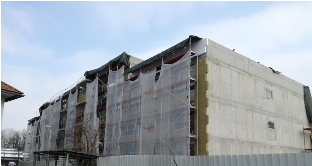
Fotografija: Večstanovanjski objekt med gradnjo – lokacija Zalog
