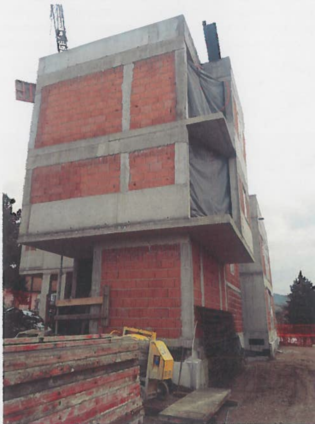
Fotografija: Pečinska ulica 2 med gradnjo (arhiv JSS MOL)
