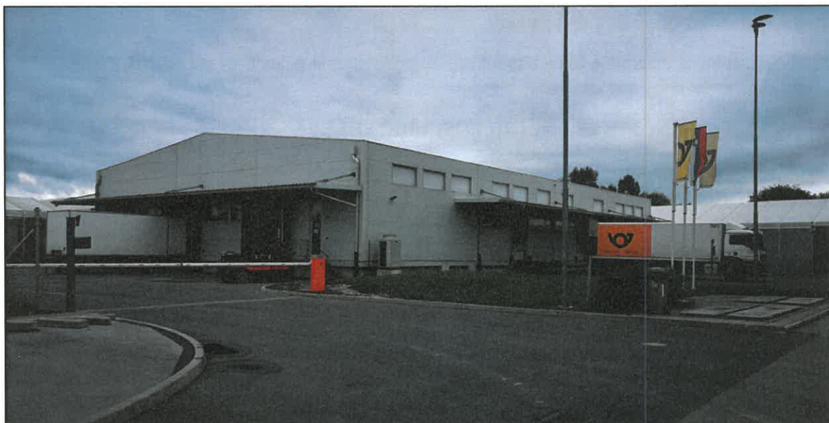
Slika 2: Obstoječi objekt na območju lokacijske preveritve, ki se ga dozida; Vir: M MUNDUS
