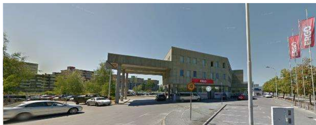
Pogled 2: Objekt B (poslovna stavba PC 128 d.o.o.)
