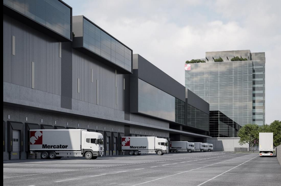
Pogled na severno fasado logistično distribucijskega objekta.
