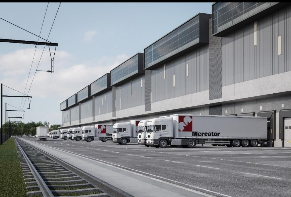
Pogled na južno fasado logistično distribucijskega objekta.
