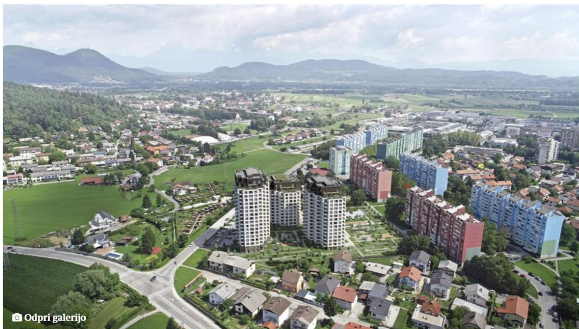
Na območju Šiške, kjer se trenutno gradi 688 stanovanj, bodo zasebni investitorji z ruskim kapitalom prihodnje leto začeli graditi sosesko Regentov kvart. FOTO: Lesnep
