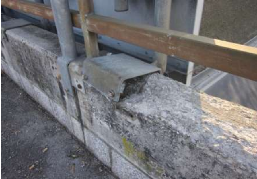
Fotografija 5 - razmajana objemka kovinske ograje, ki drži usmerjevalno tablo nad obvoznico
