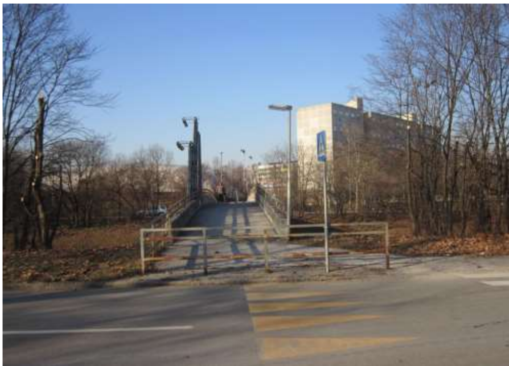
Foto 1: Most za pešce/nadhod nad avtocesto - slikano v smeri s Šiške proti Dravljam.
