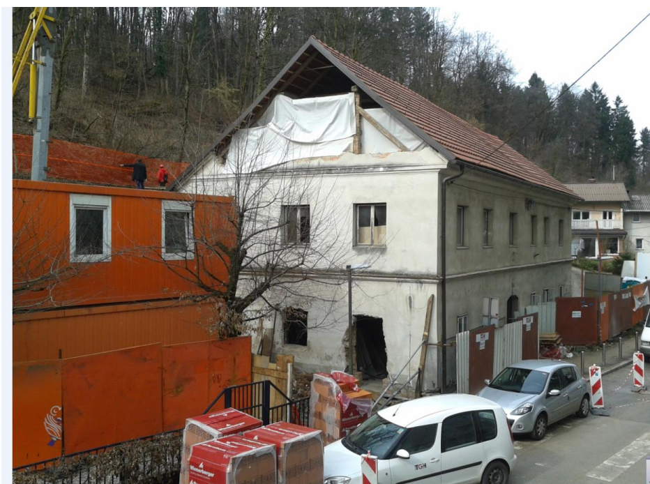
Fotografija: Stavba Vodnikova 5 med izvajanjem del
