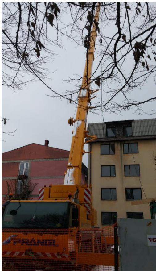
Fotografija: Stavba Hladilniška 34 med izvajanjem del
