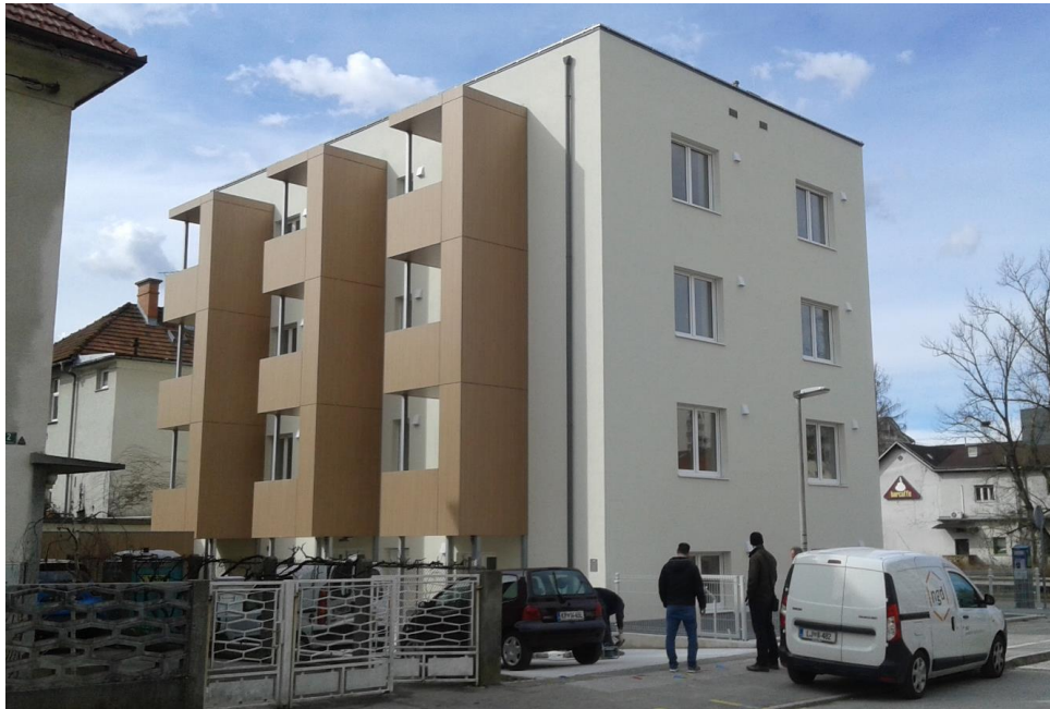
Fotografija: Stavba Ob Ljubljani 42 v zaključnih fazah rekonstrukcije
