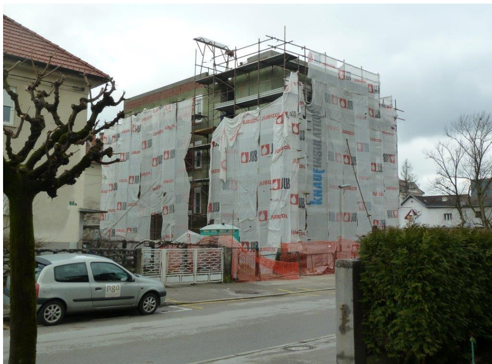
Fotografija: Izvajanje del na objektu »Ob Ljubljani 42«
