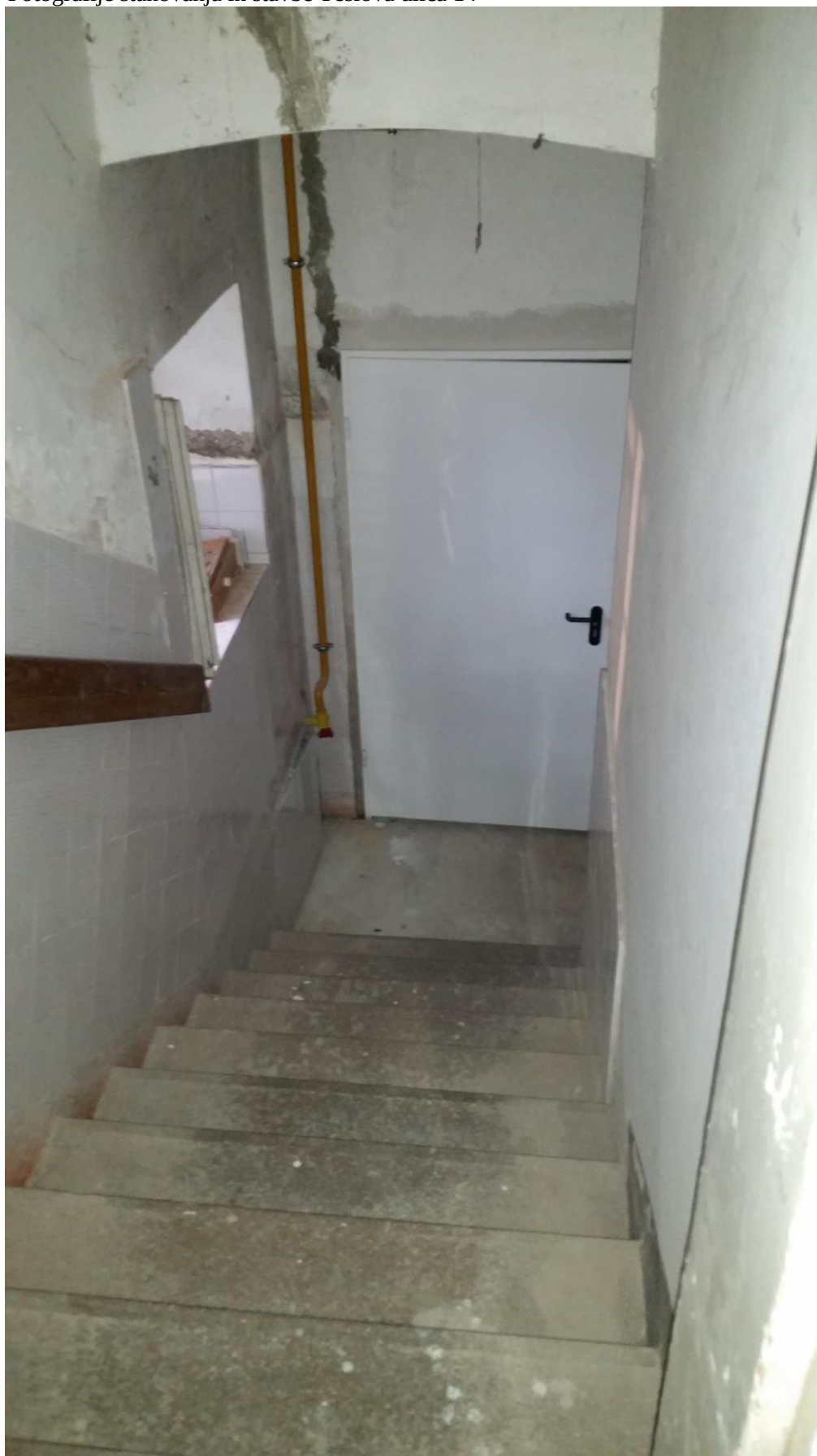
Fotografije stanovanja in stavbe Teslova ulica 14
