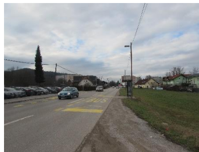
9b: Litjska cesta, pogled proti zahodu na avtobusno postajališče Rast
