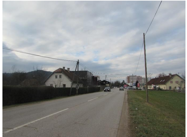
6b: Litjska cesta, pogled proti zahodu
