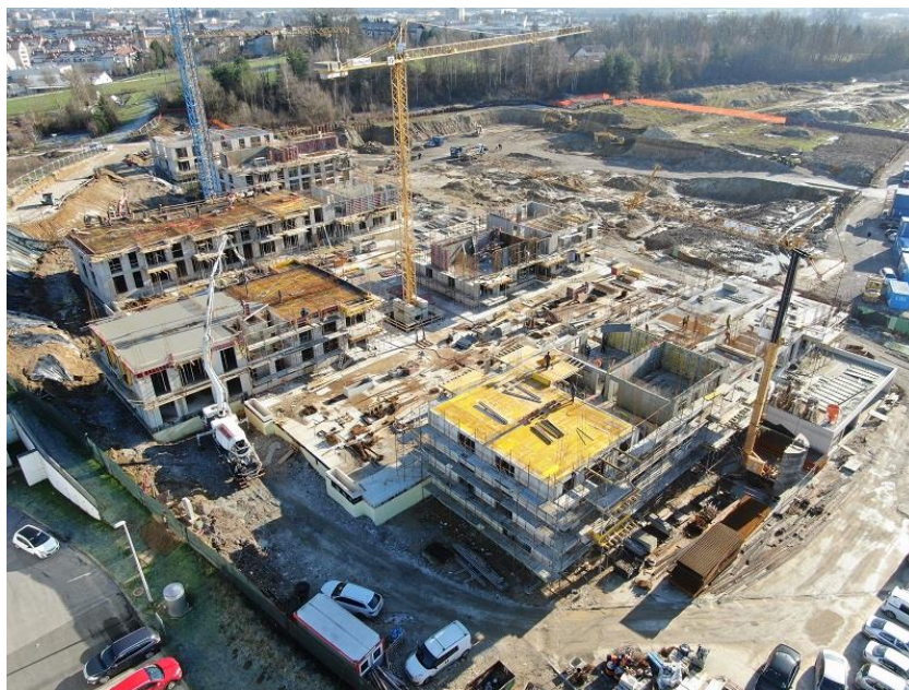
Fotografija: Gradnja Stanovanjske soseske Novo Brdo, E1, na dan 12.12.2019
