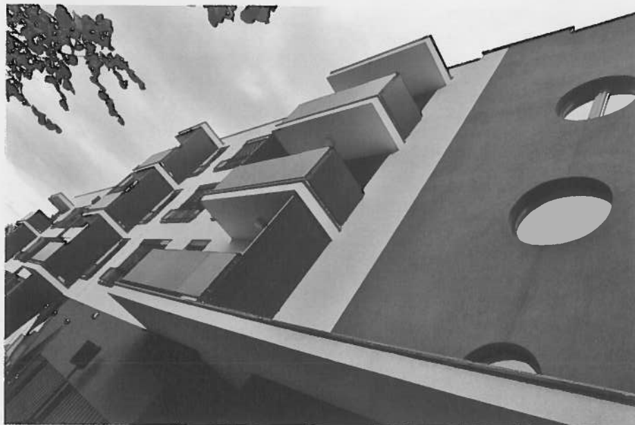
Fotografija: Severna (vhodna) fasada večstanovanjske stavbe na Zaloški 273
