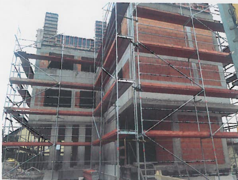
Fotografija: Stanovanjska stavba Pečinska 2 med gradnjo
