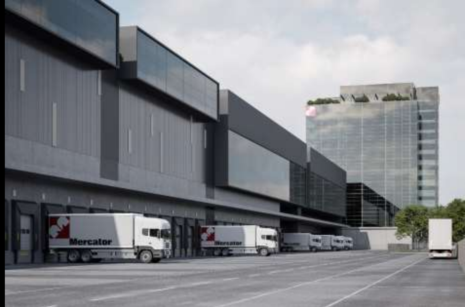
Pogled na severno fasado logistično distribucijskega objekta.
