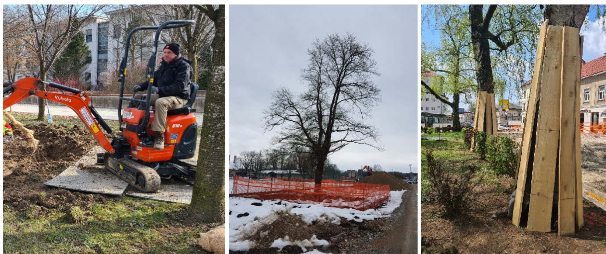
Slika 6: Levo: Plozovne plošče prerazporedijo težo stroja in varujejo območje drevesnih korenin. Zaščita območja drevesnih korenin (sredina) in zaščita debel (desno) na gradbiščih.
