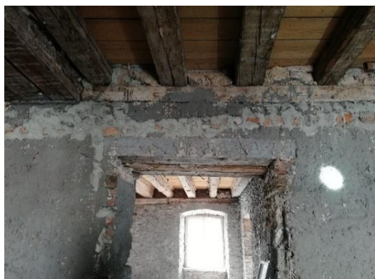
Slika 5: Lega v obstoječi steni kot ležišče stropnikov, nad vratno odprtino sta razvidni tako lesena kot opežna preklada
