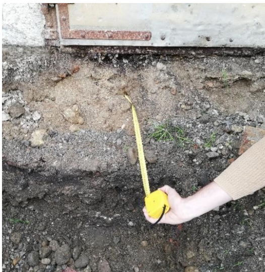
Slika 1: Prikaz razširjenega dela temelja na zahodni (pročelni) fasadi
