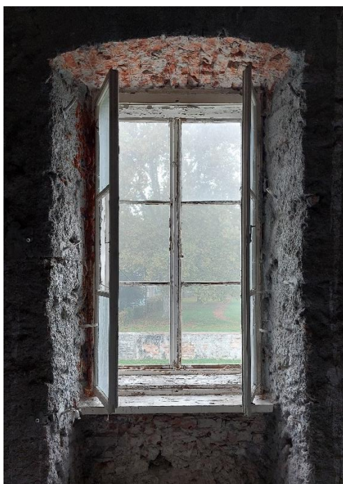
Sliki 11 in 12: Pogled na okno z notranje strani - pri obstoječem stanju ne gre za škatlasto okno, ampak vgradnjo obeh oken v nivo obstoječega ostenja
