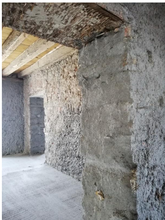
Slika 4: Prikaz trstike za sprimnost ometa na prekladi obstoječe vratne odprtine
