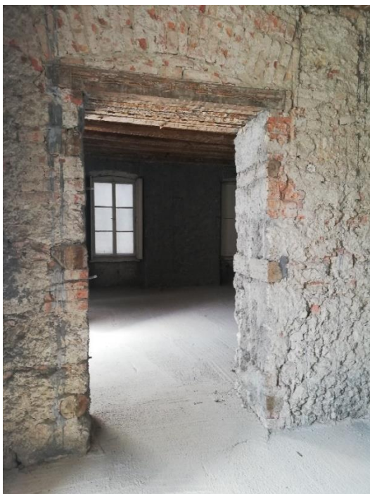
Slika 3: Prikaz opečne in lesene preklade nad obstoječo vratno odprtino
