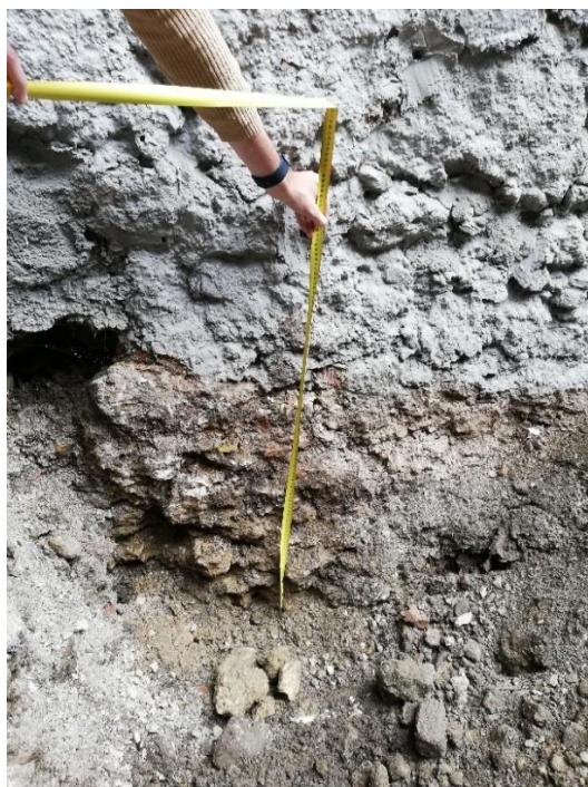
Slika 2: Prikaz temelja na vzhodni fasadi
